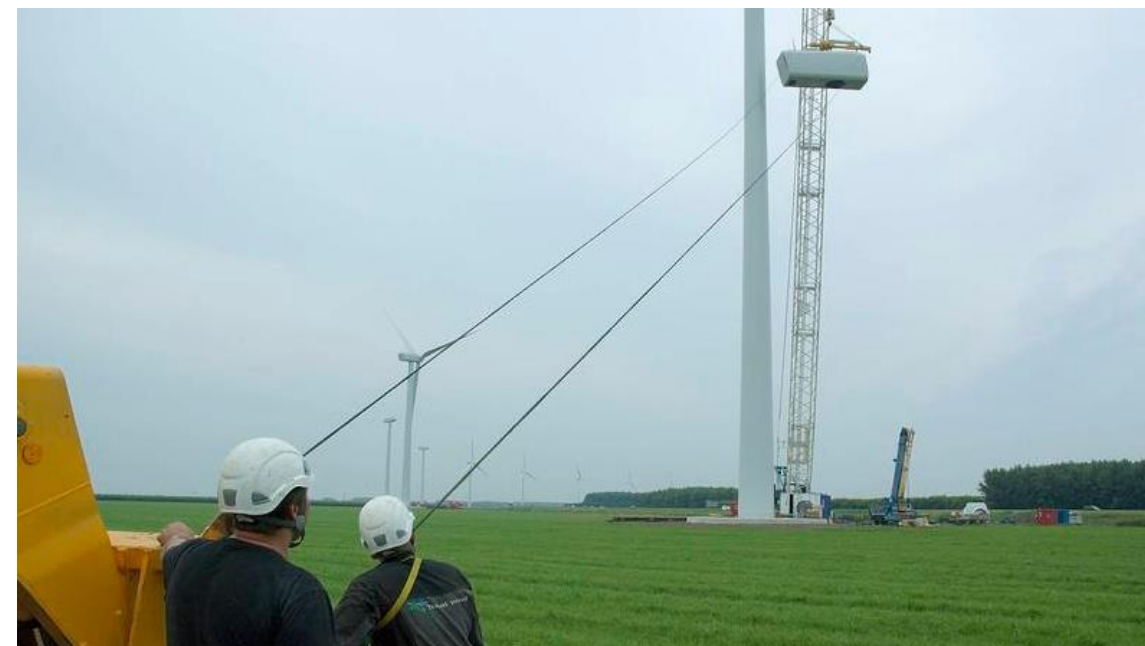
Photo 32 : Montage de la nacelle
