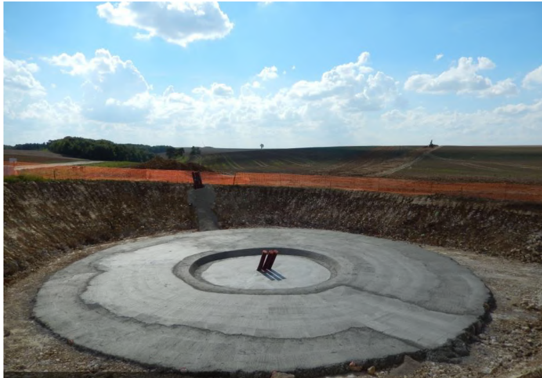
Photo 18 : Béton de propreté
