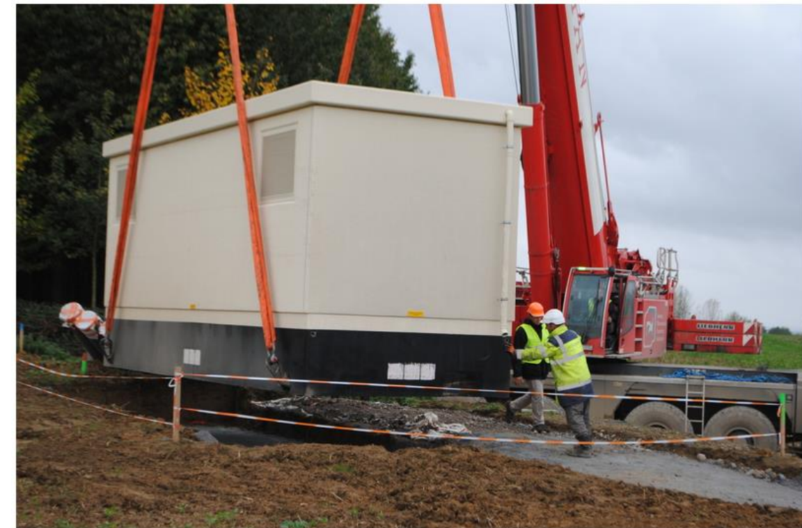
Photo 25 : Pose d'un poste de livraison
