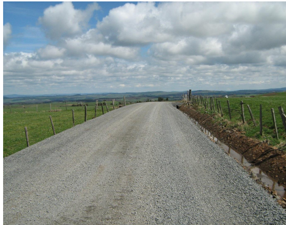
Photo 16 : Voie d'accès terminée
