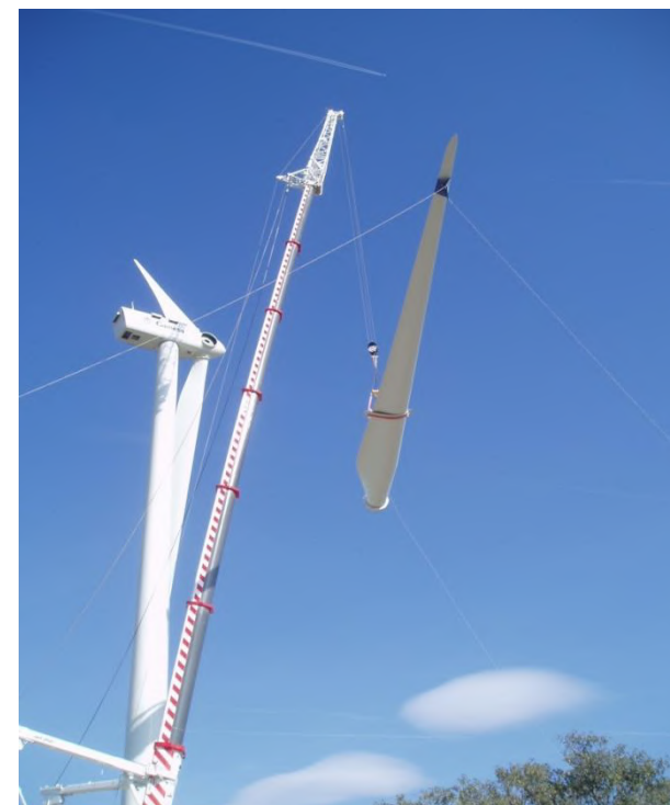
Photo 35 : Montage pale par pale
