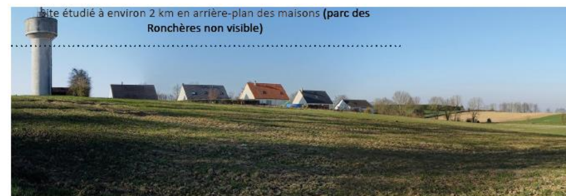
Photo 56 : Vue vers le sud-ouest sur une extension pavillonnaire et château d'eau au nord de Sains
