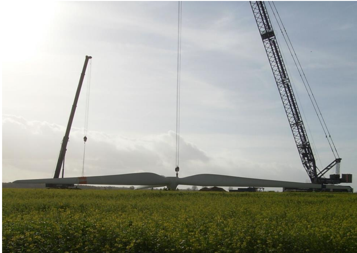
Photo 33 : Assemblage du rotor au sol
