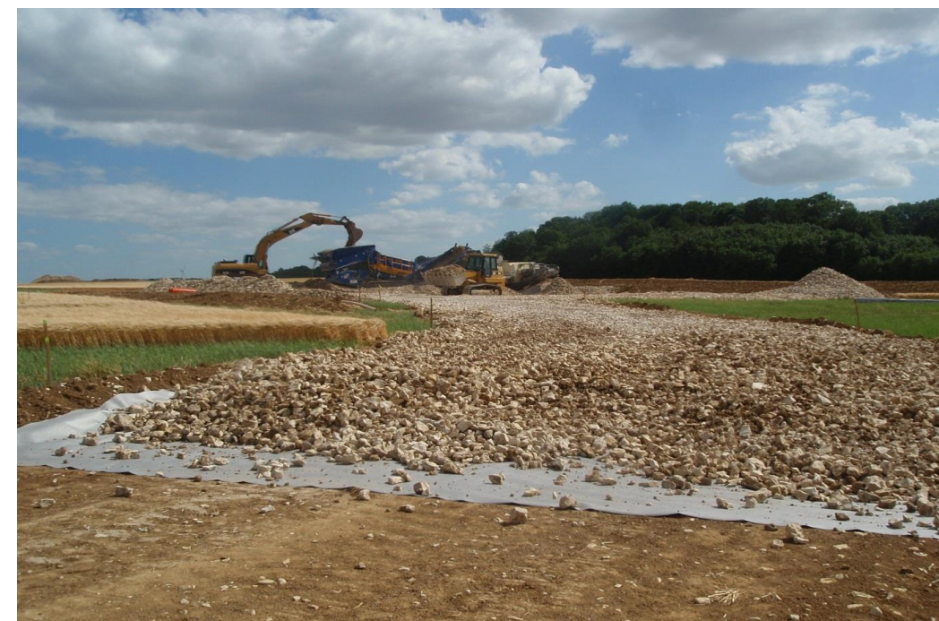
Photo 14 : Suivant le besoin, pose d'une bâche textile et de graves concassées
