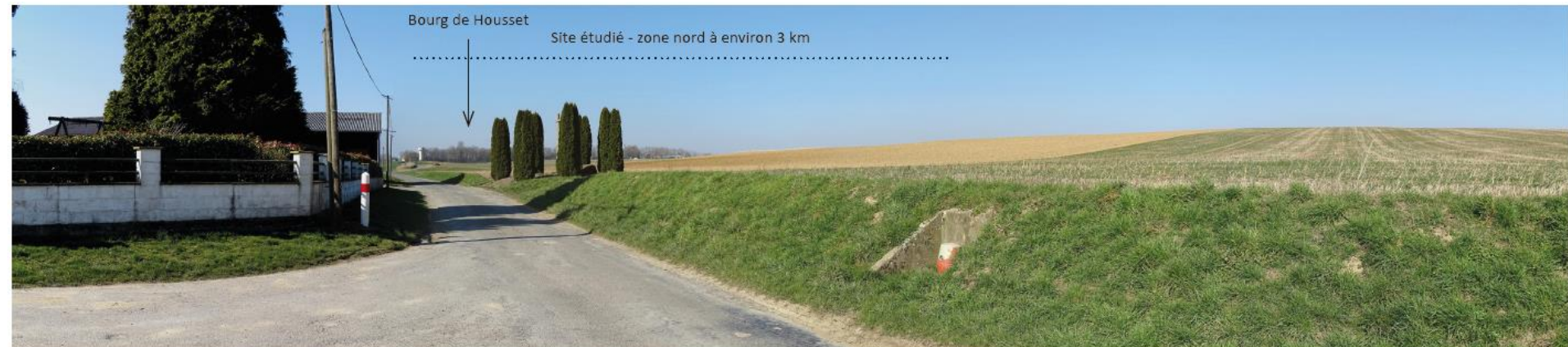
Photo 58 : Vue vers le nord-ouest depuis la Neuville-Housset sur la RD588
