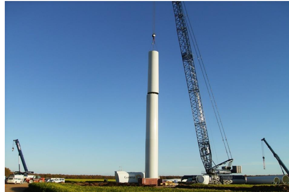
Photo 31 : Montage des éléments de la tour
