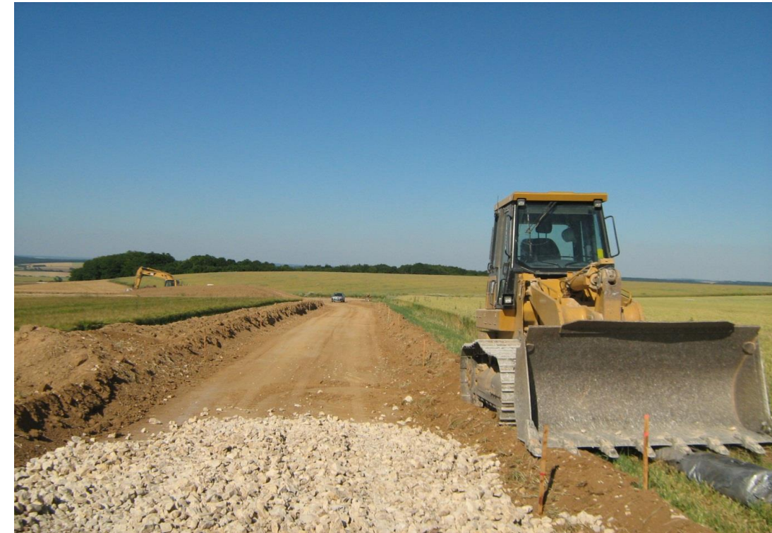
Photo 13 : Décapage du sol
