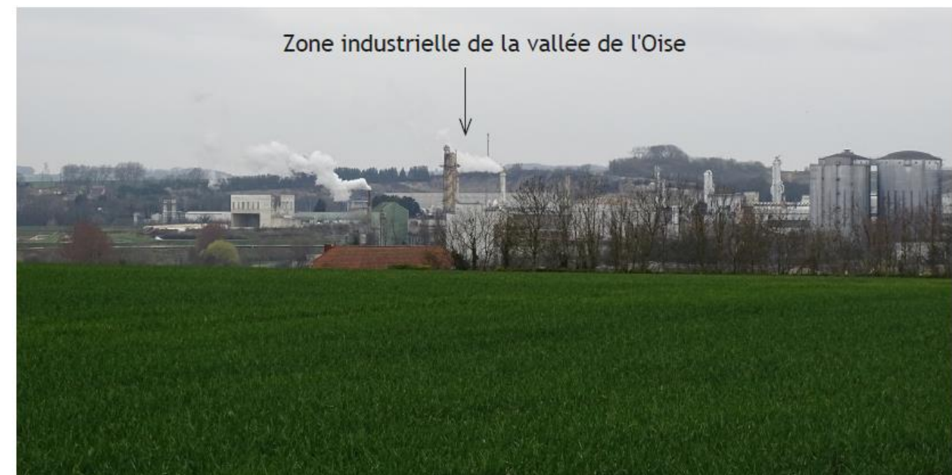
Photo 50 : Vue vers l'ouest sur une zone industrielle de la Vallée de l'Oise depuis la RD29
