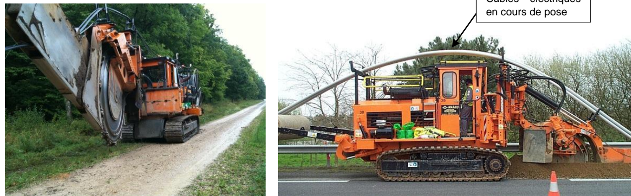
Photo 26 et Photo 27 : Trancheuse à l'arrêt et en action
