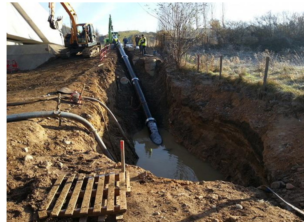
Photo 29 : Exemple de point de départ avec canalisation engagée
