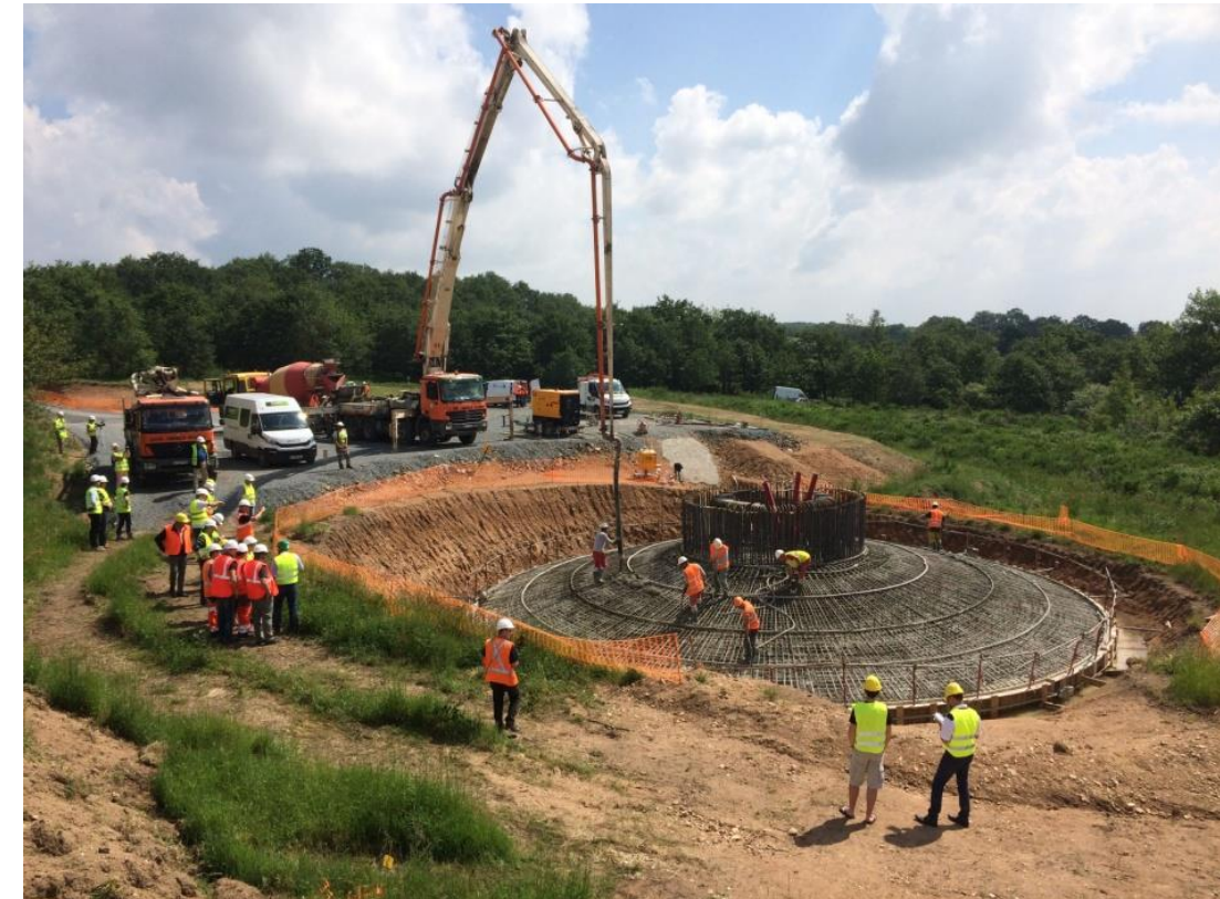
Photo 20 : Coulage du béton
