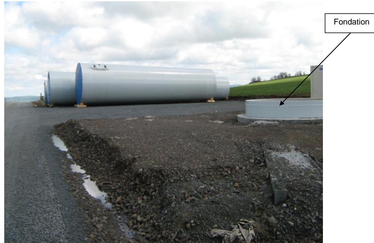
Photo 30 : Stockage des éléments de l'éolienne sur la plateforme à proximité de la fondation
