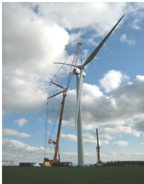
Photo 34 : Montage du rotor
