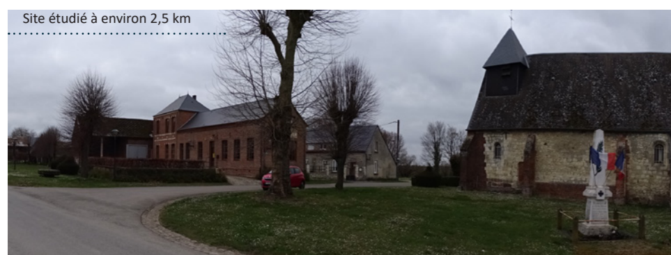
Photo 40. Vue dans le centre-bourg de la Neuville-Housset.
