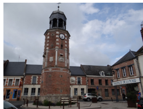
Photo 89. Ancien beffroi de Crécy-sur-Serre
