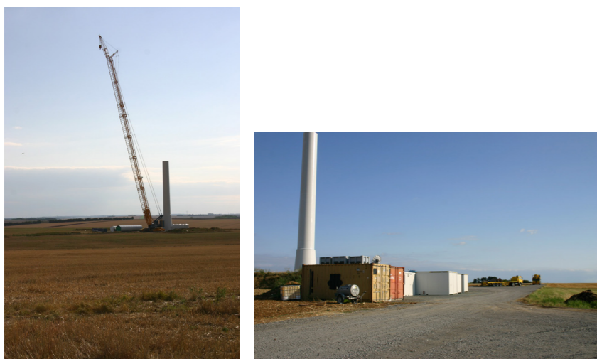
Fig. 21. Exemples de chantier de construction d'un parc éolien
