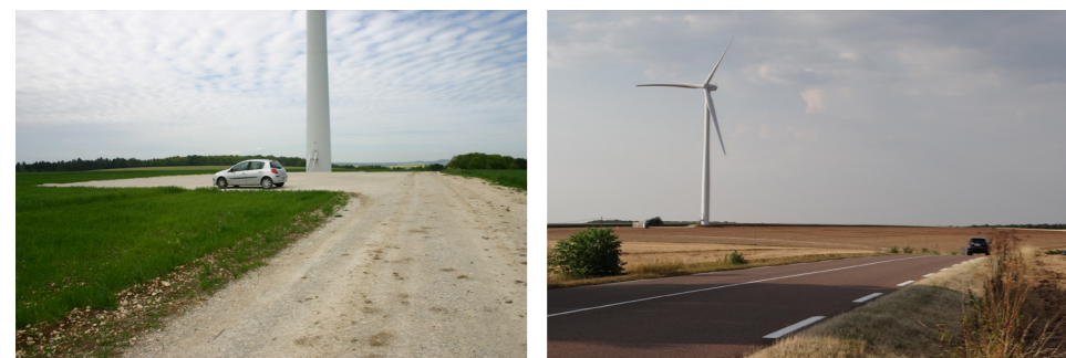
Fig. 22. Exemple de piste d'accès et de plateforme d'un parc éolien
