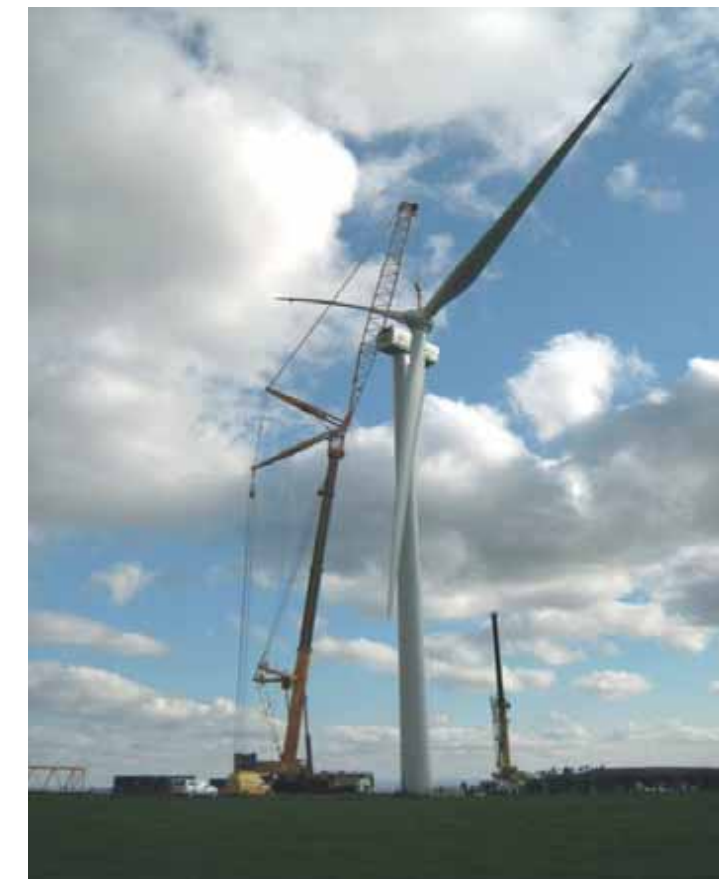
Photo 13 : Montage du rotor
