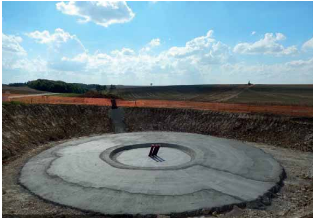
Photo 7 : Béton de propreté
