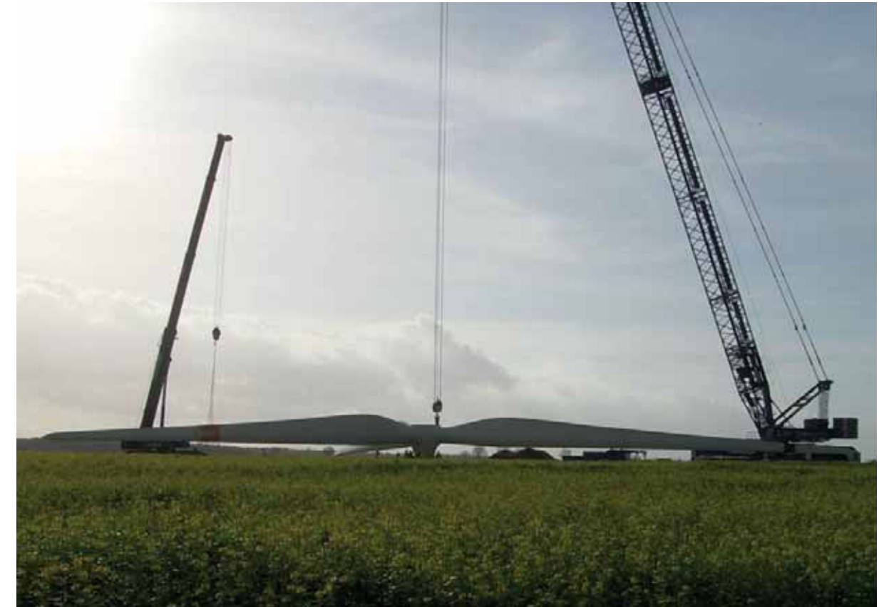
Photo 12 : Assemblage du rotor au sol
