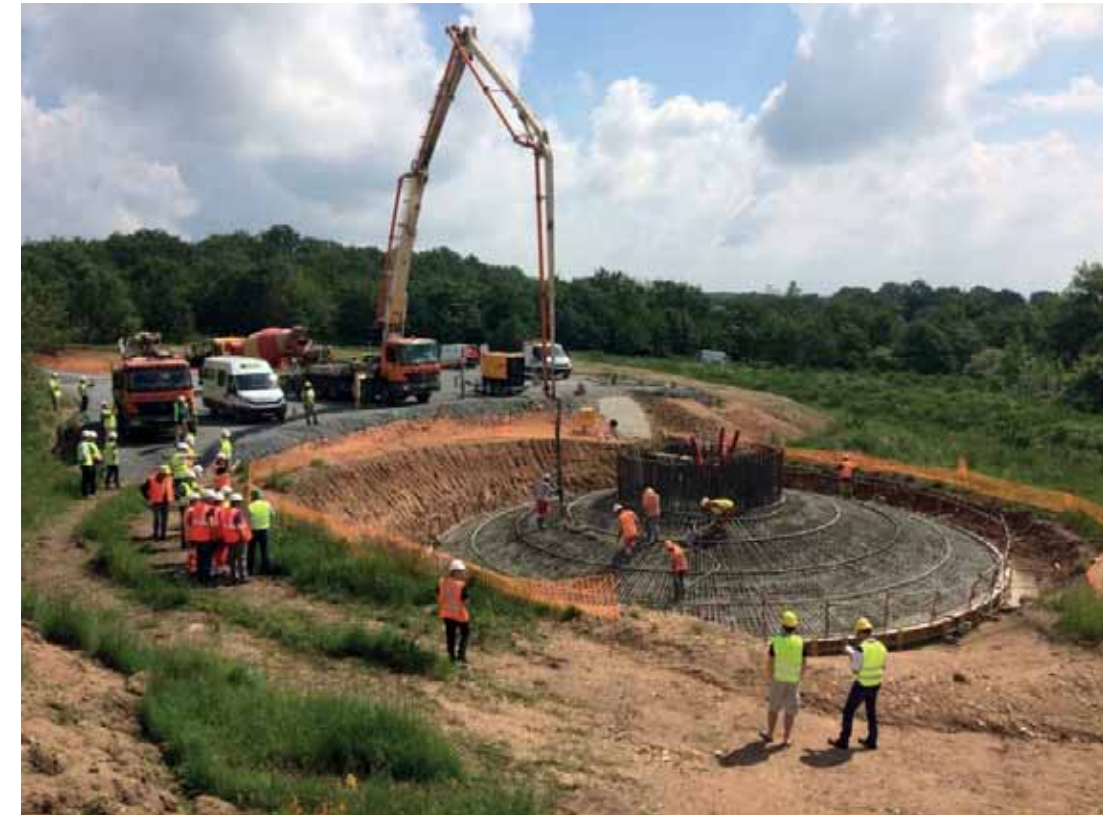
Photo 9 : Coulage du béton
