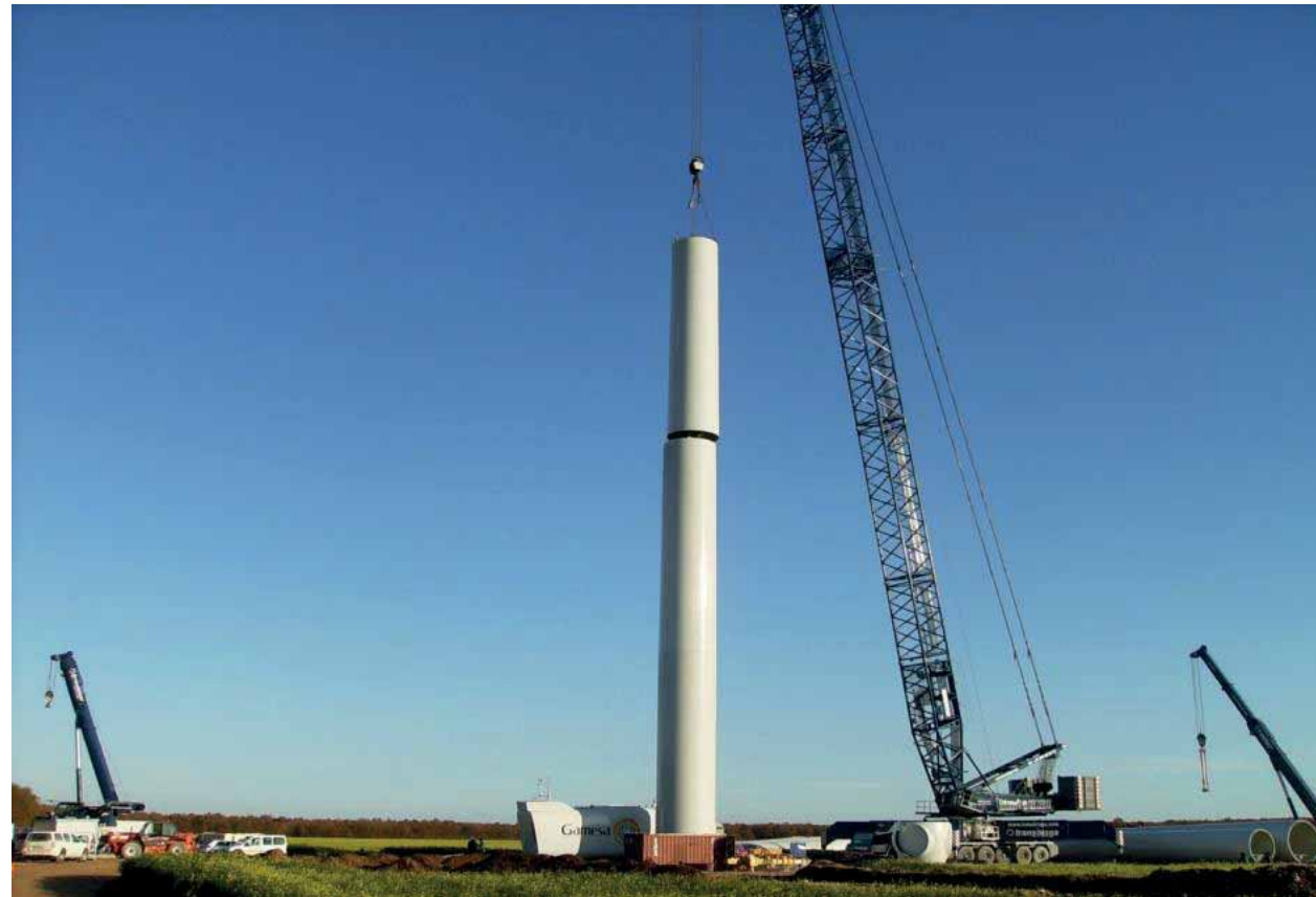
Photo 11 : Montage des éléments de la tour
