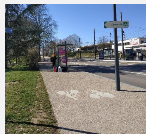
Voie verte sur le trottoir, avenue de la paix (RD683) à Besançon, non séparée du trottoir.
