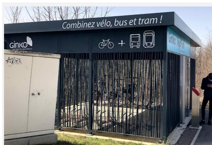
Abris vélo sécurisé Ginko Vélo park
