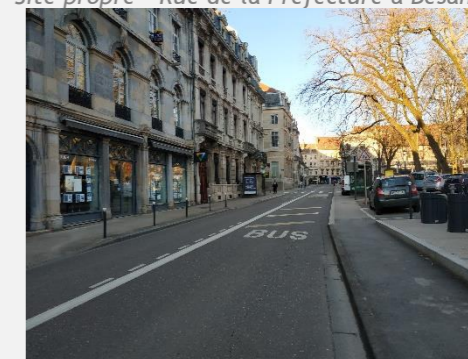
Site propre - Rue de la Préfecture à Besançon
