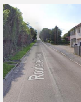
RD408 : Ambiance routière sur la traversée de Marchaux © Google
