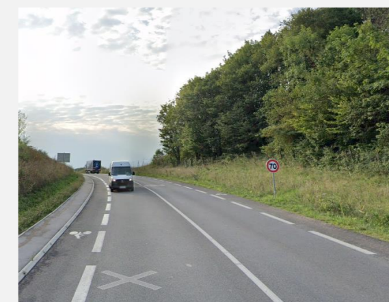
Bandes cyclables, rue Ariane II à Miserey Salines, non adaptées à une chaussée interurbaine à fort trafic limitée à 70 Km/h (source : @Google)
