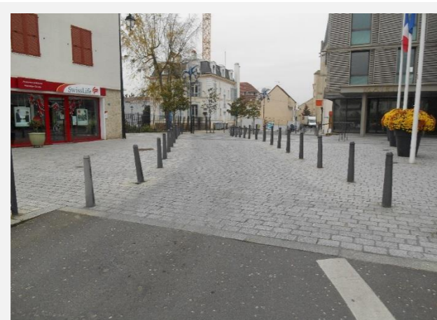
Reprise totale de l'aménagement de voirie en Z30 aux Mureaux - Source CEREMA
