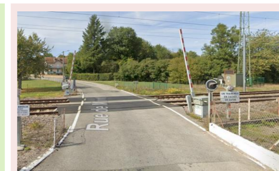
Passage à niveau sans espace pour la circulation des piétons @GoogleMaps
