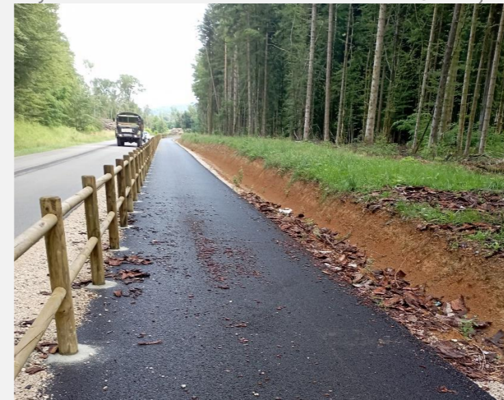
Aménagement cyclable réalisée sur l'axe RD105 entre La Marne et Chateaufarine (Besançon)
