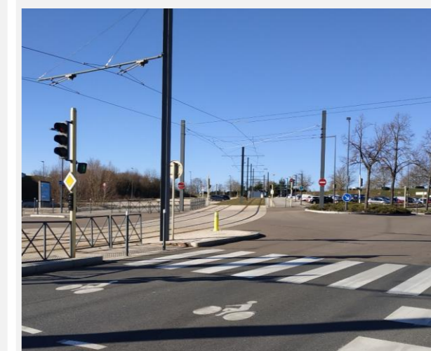
Traversée conforme avec plot, abaissement, marquage au sol et bande podotactile - Boulevard Alexandre Fleming Besançon
