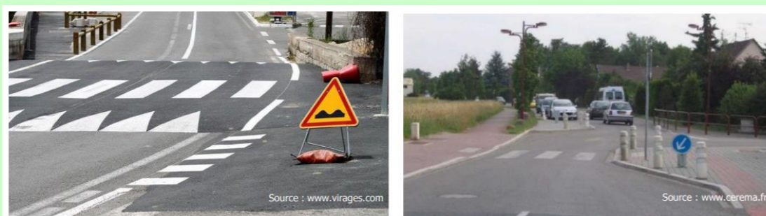
Décrochement vertical de type plateau surélevé (à gauche) et décrochement vertical de type écluse (à droite)
