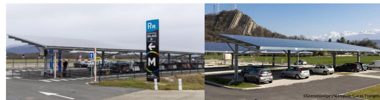
Parking relais avec Ombrières (source : grenoblealpesmetropole.fr - Ombrière photovoltaïque (smmag.fr))
