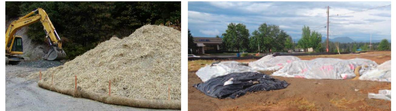
Figure 167 - Exemples de protection des dépôts provisoires à l'aide de paillage par mulch (à gauche) et de géomembranes (à droite) [Guide des bonnes pratiques environnementales – Protection des milieux aquatiques en phase chantier, AFB, 2018]
