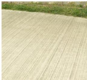
Pour les autres voies, sur lesquelles est attendue une circulation moins intense et à plus faible vitesse, les revêtements de sols sont prévus en béton à base de ciment gris avec une finition en béton balayé.
