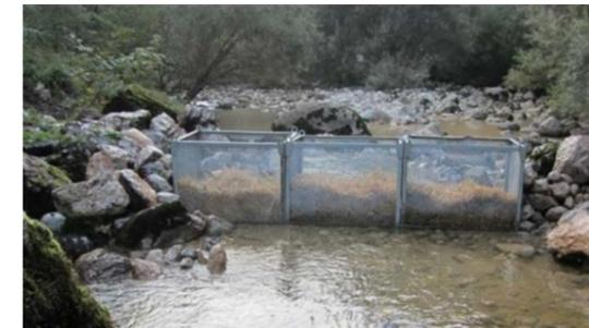
Figure 165 - Exemple filtre grillagé contenant de la paille
