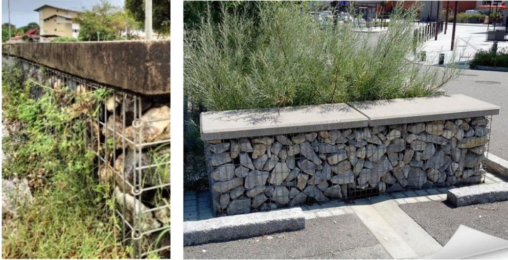
Banc en gabion avec assise en béton
