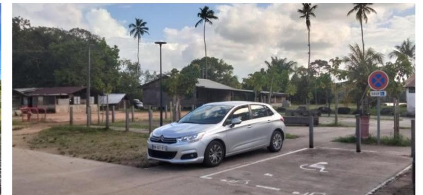
Parking en dalles alvéolaires et place PMR en béton finition balayée
