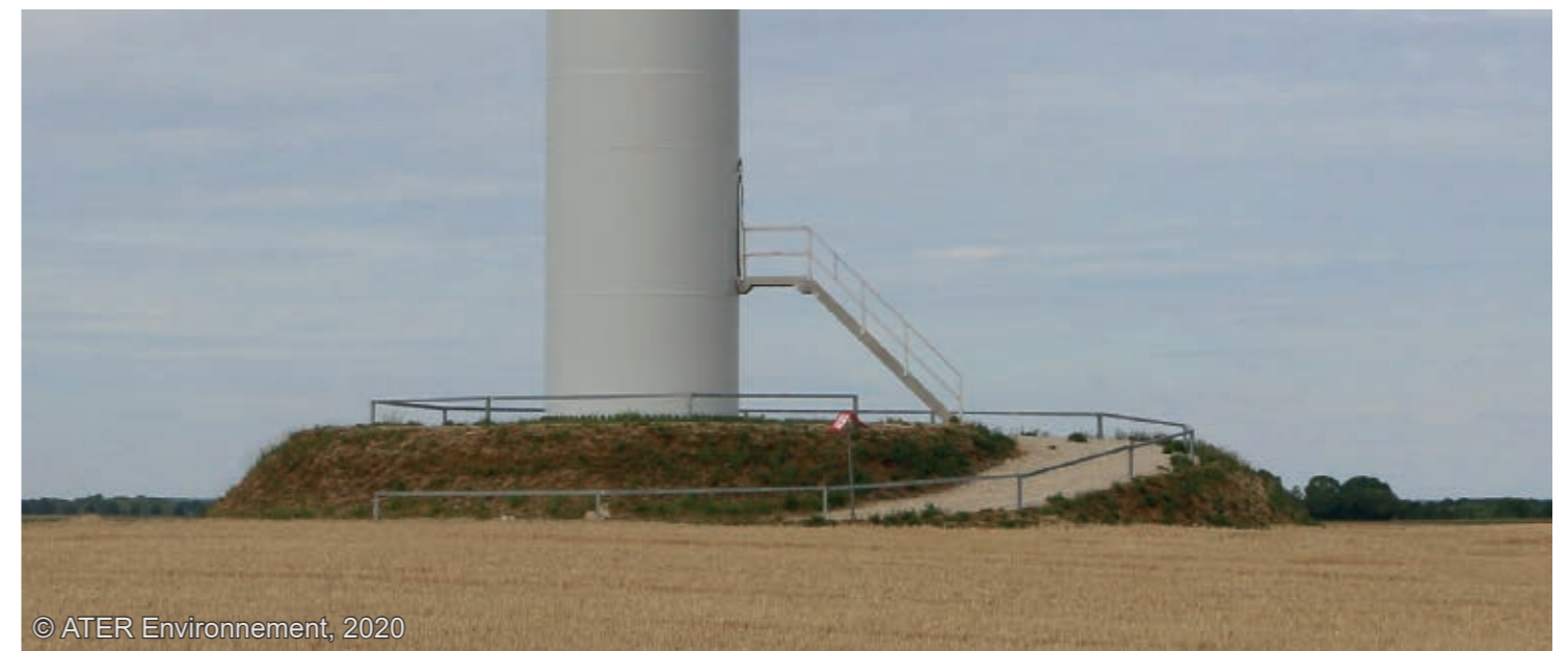
Fig. 158 : Fondation surélevée avec remblai
