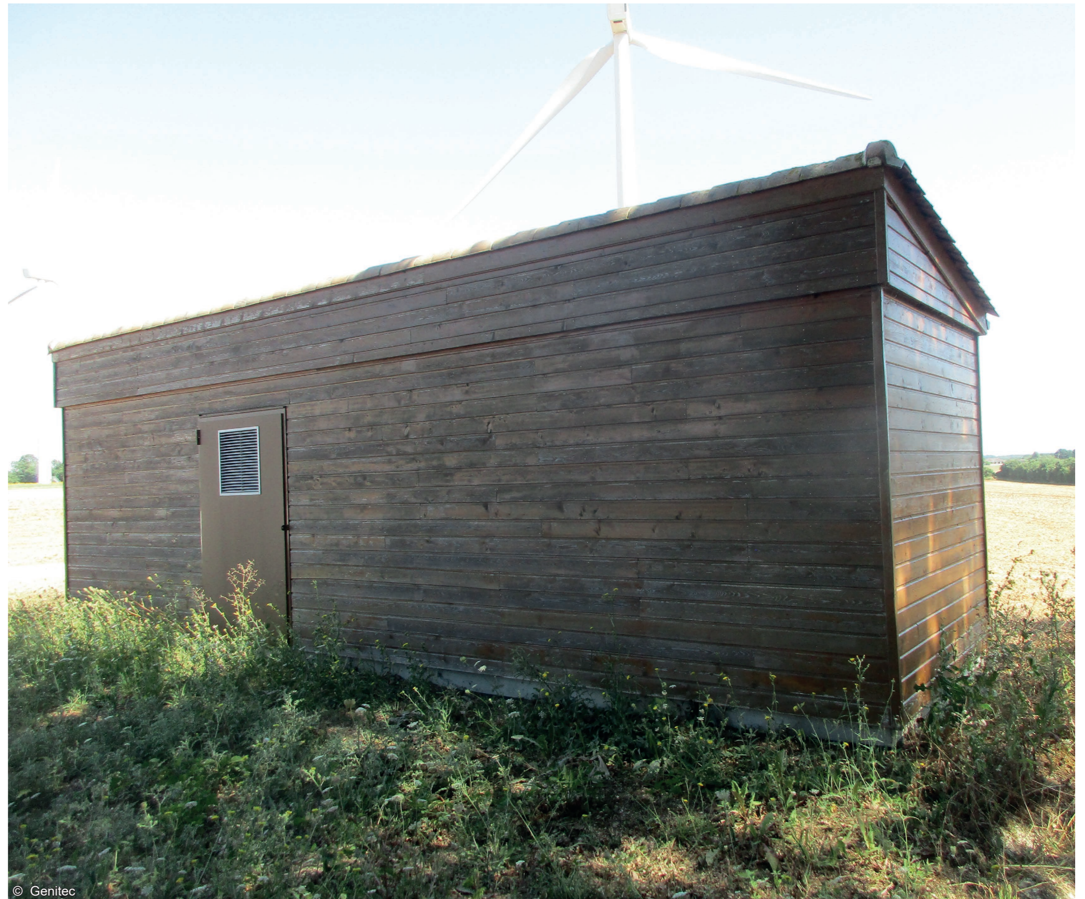
Fig. 207 : Exemple d'un poste de transformation en bardage bois horizontal et toit en tuiles
