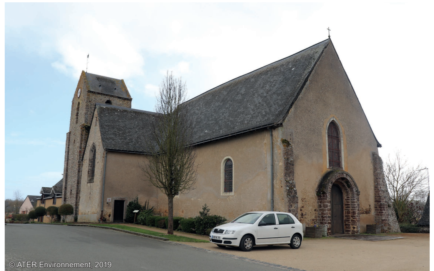
Fig. 49 : Eglise de Saint-Denis-du-Maine
