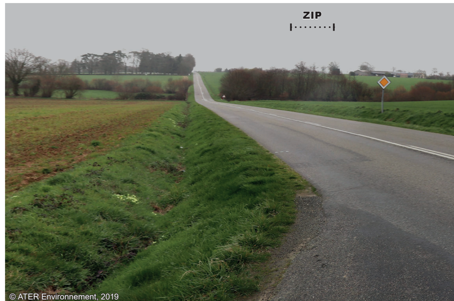
Fig. 66 : Vue depuis la départementale 4 à l'Ouest de la zone d'implantation potentielle, en direction de Quelaines
