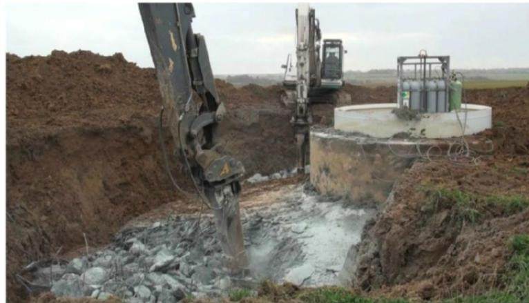
Figure 54 : Démantèlement d'un parc éolien à Criel-sur-Mer (source : Quénéa, 2020)
