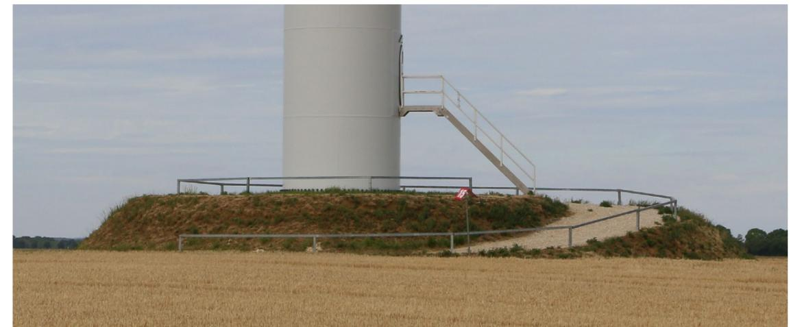
Figure 45 : Fondation surélevée avec remblai (source : Enercon, 2020)
