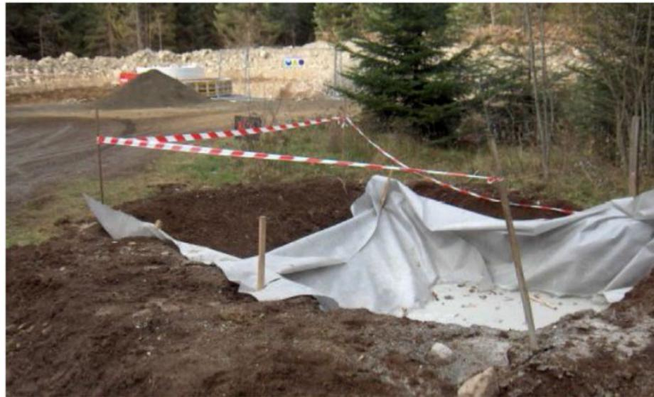
Figure 51 : Excavation pour déchet à proximité d'une plateforme temporaire (source : Quénéa, 2020)
