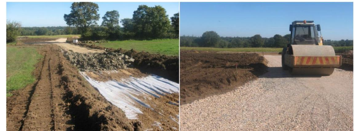
Figure 53 : Construction et terrassement des voies d'accès (source : ARVRO Energies, 2020)
