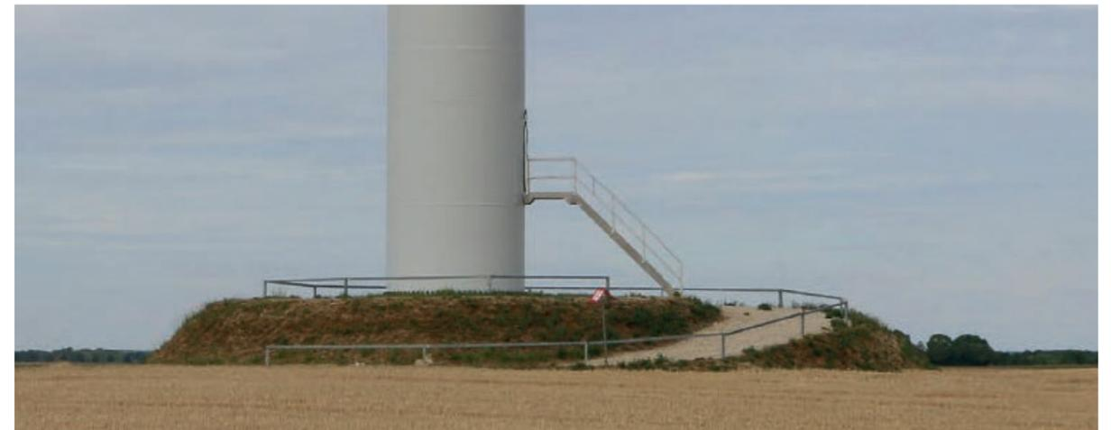
Figure 39 : Fondation surélevée avec remblai (source : ATER Environnement, 2021)
