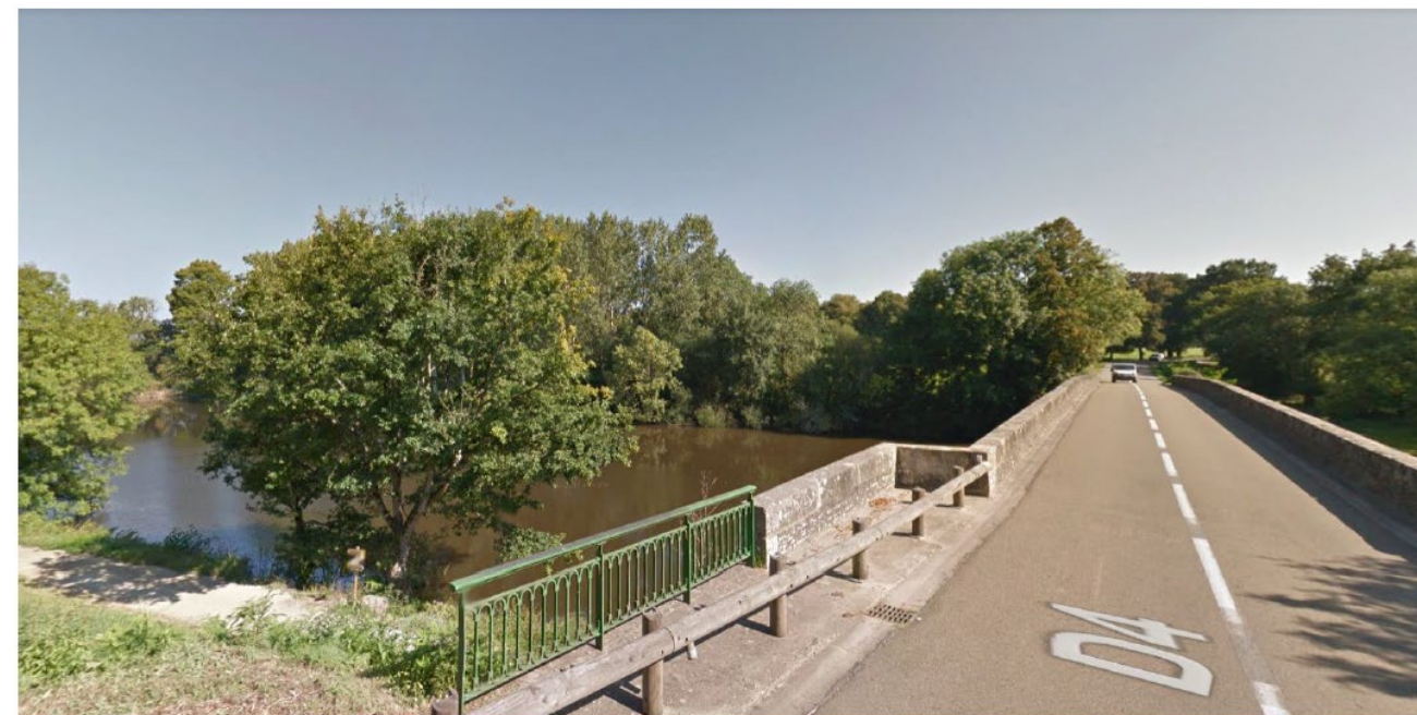
Figure 250 : Franchissement de la Mayenne et de la ZNIEFF de type I « La Rongère » au niveau de la RD4 à la sortie du bourg d'Houssay (source : Biotope, 2024)
