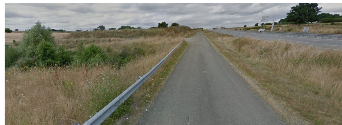
Figure 251 : Franchissement d'un affluent de la Mayenne au niveau de la N162 à proximité de l'intersection avec la RD 4 (source : Biotope, 2024)
