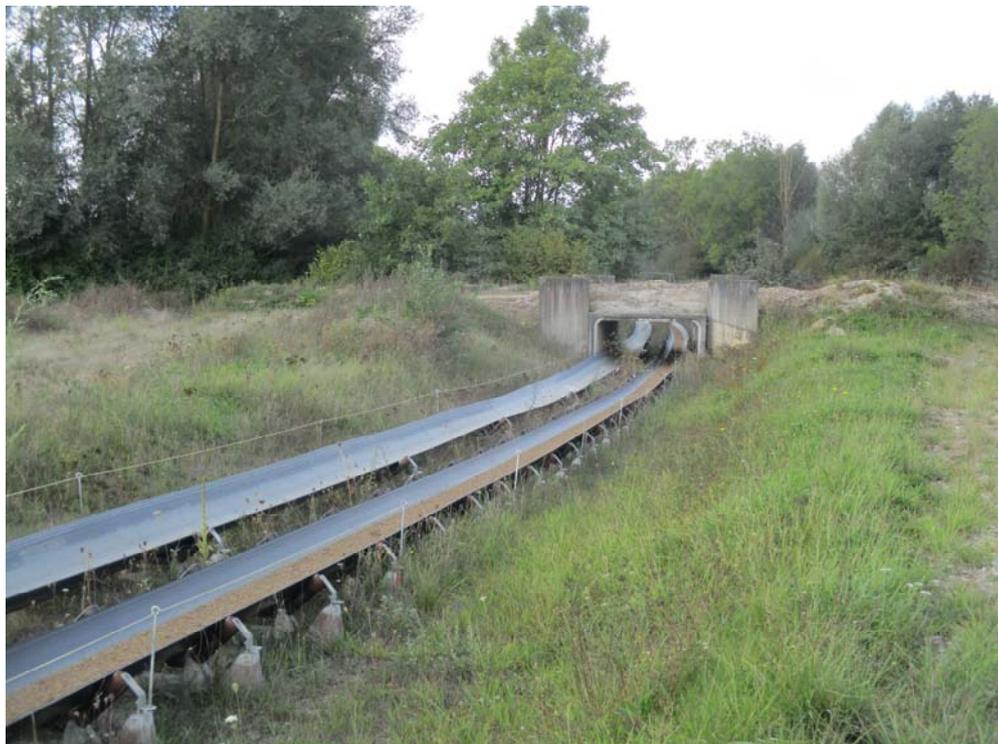
Compte tenu de la profondeur de la nappe et de la faible hauteur des bandes (aller et retour côte à côte), il y a peu de risque que ces tunnels puissent être noyés en période de crue de la nappe.
