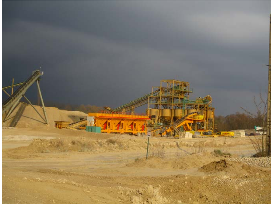
Stock tampon et installation MORONI d'Orconte
