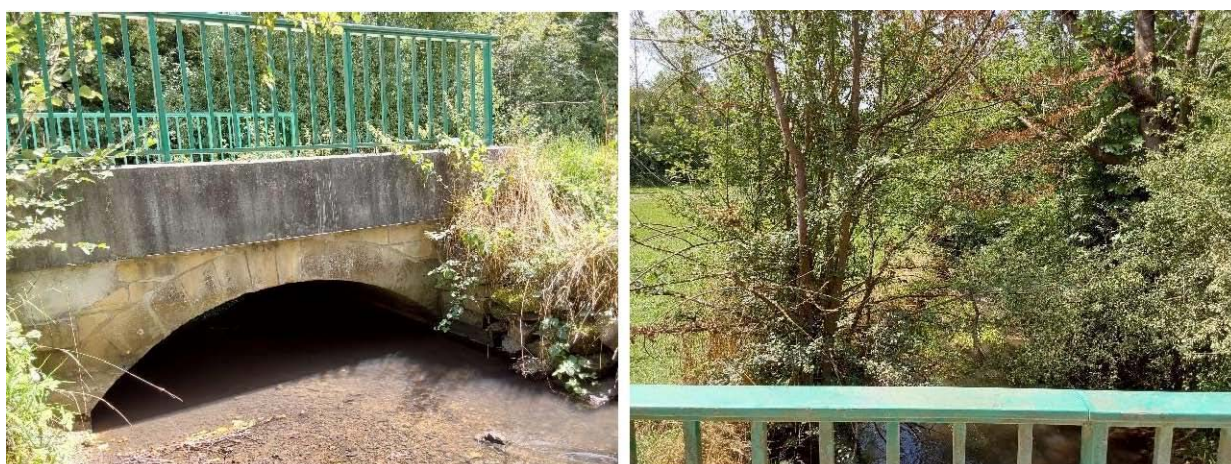
En amont du site sous le chemin menant à la station d'épuration de la commune d'Orconte
