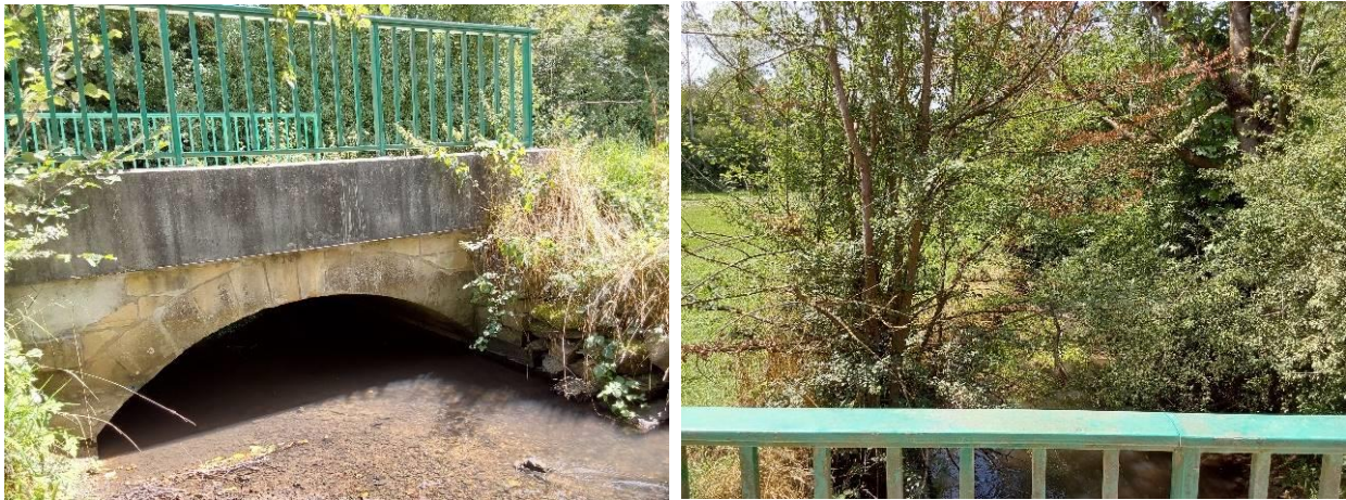
Figure 11 : En amont du site sous le chemin menant à la station d'épuration de la commune d'Orconte
