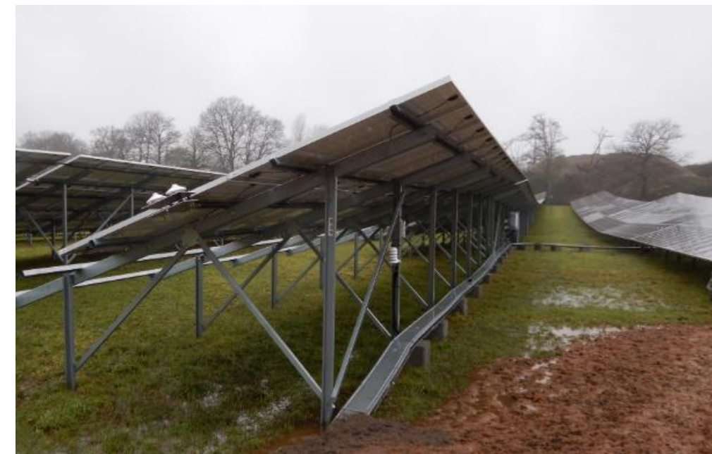
Photographie 6 : Exemple de liaisons électriques aériennes (Source : ENCIS Environnement)
