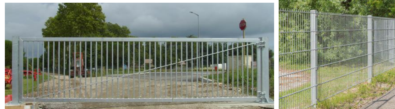
Photographie 8 : Clôture de sécurité et portail d'accès (Source : SE 44)
