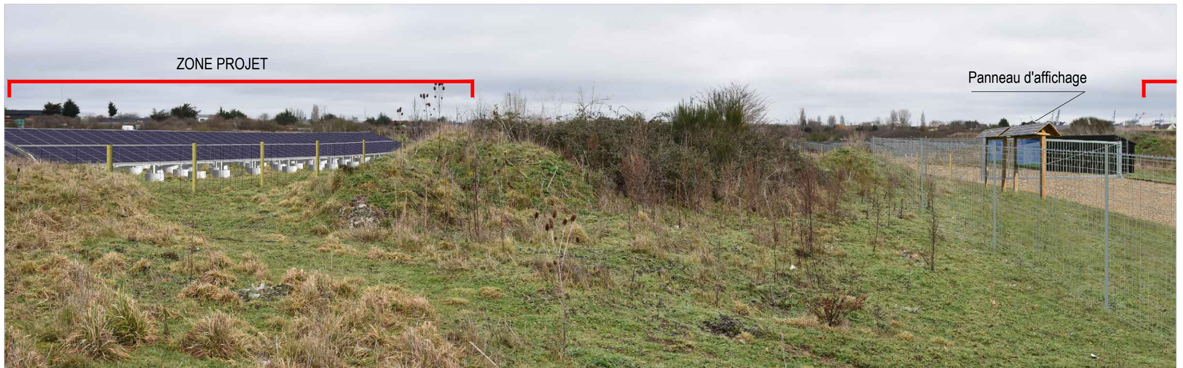
Après travaux - Zoom
