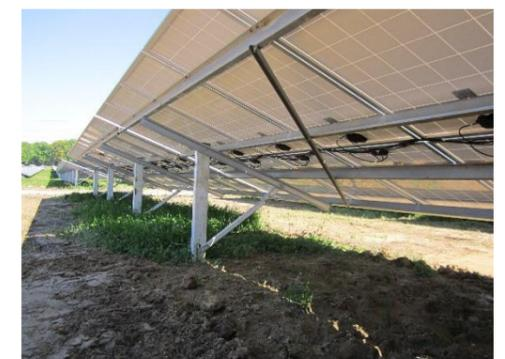
la topographie, des fixations inclinables seront utilisées, permettant d'adapter les structures au modelé du terrain.
