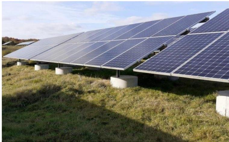
Photographie 47 : Structures porteuses en plot béton (source : SE44/CARENE)
