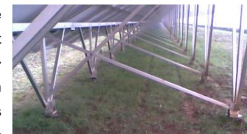
Après la phase chantier, le couvert végétal pouvant être dégradé par endroit, il sera possible de constater un léger creusement au droit des panneaux. Lorsque le couvert végétal aura retrouvé sa densité initiale, l'effet sera annulé. La hauteur de chute de l'eau étant seulement de 1 m et la pente du terrain étant nulle, l'érosion provoquée sera quoiqu'il en soit toujours très limitée.
