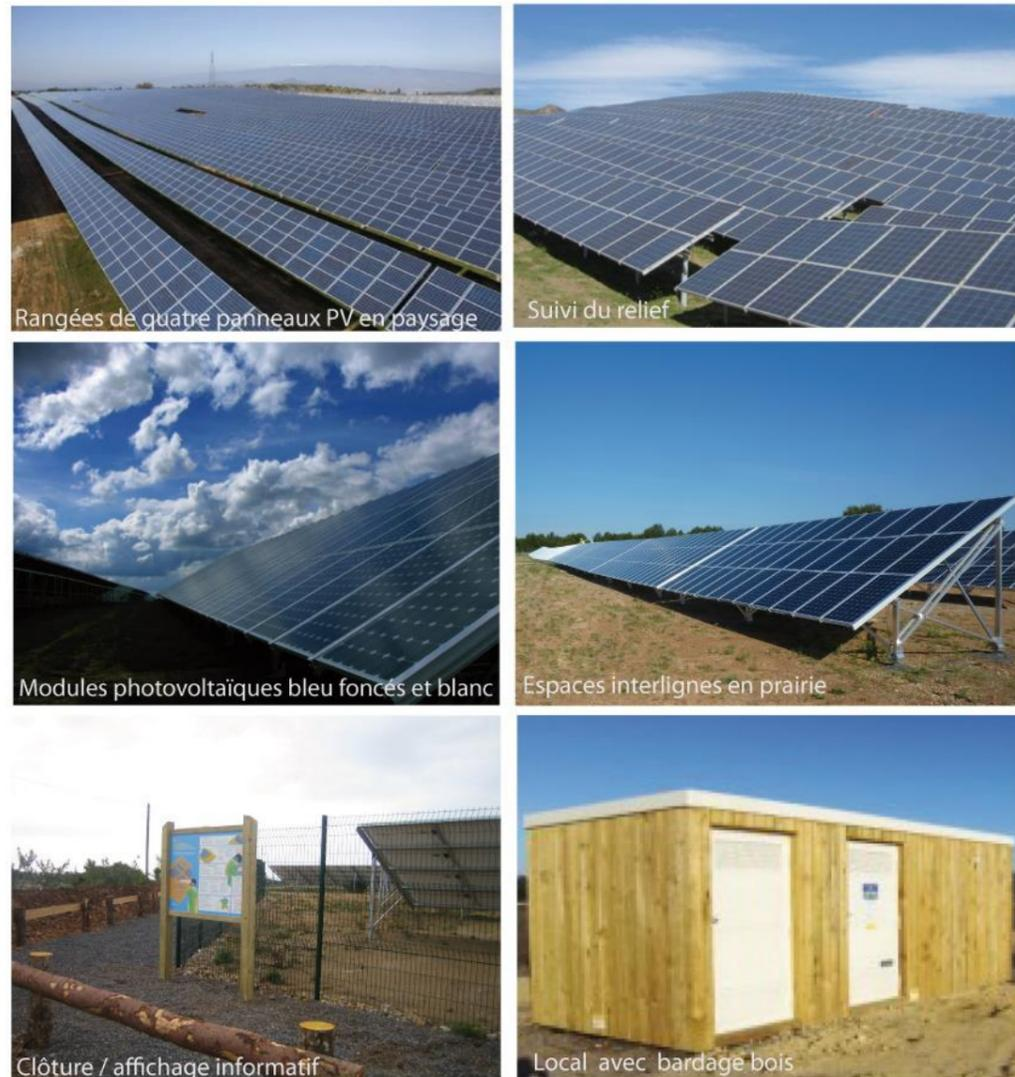
Photographie 32 : Exemples de centrales photovoltaïques au sol
