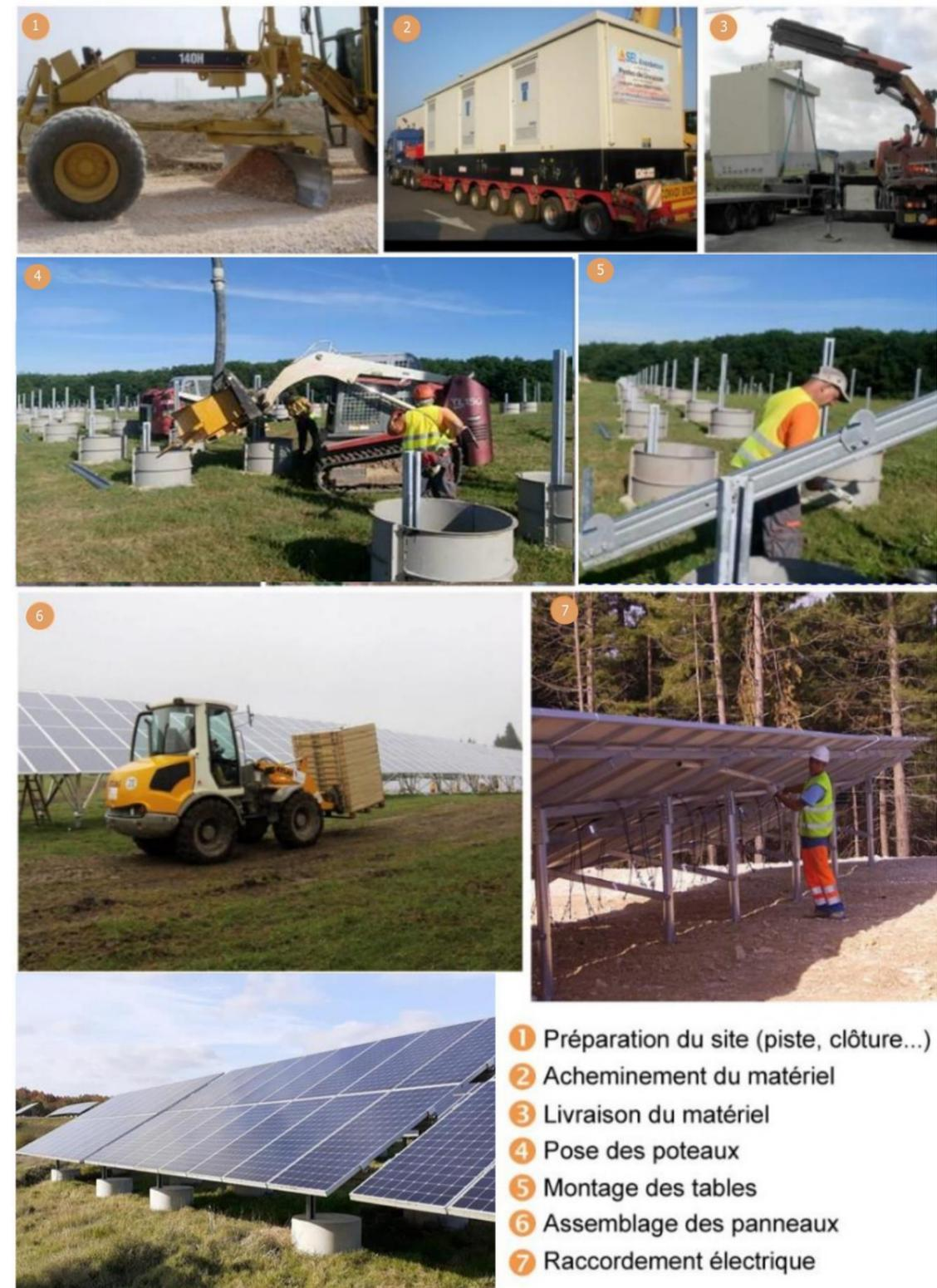
Photographie 51 : Construction d'une centrale photovoltaïque (source : ENCIS Environnement)
