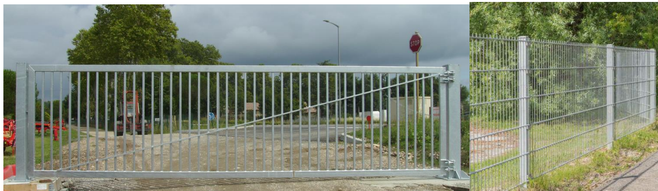
Figure 5 Portail et clôture à grillage soudé double fils (source : SE44)
