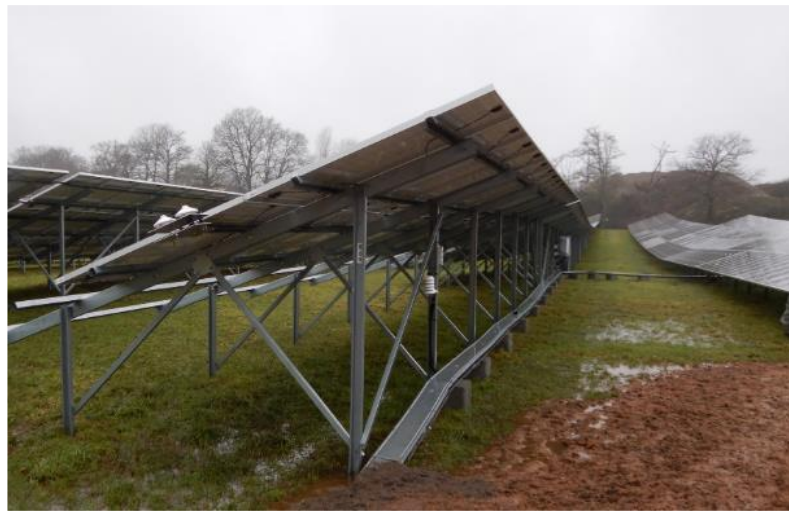
Figure 3 Chemin de câble aérien (source : ENCIS environnement)
