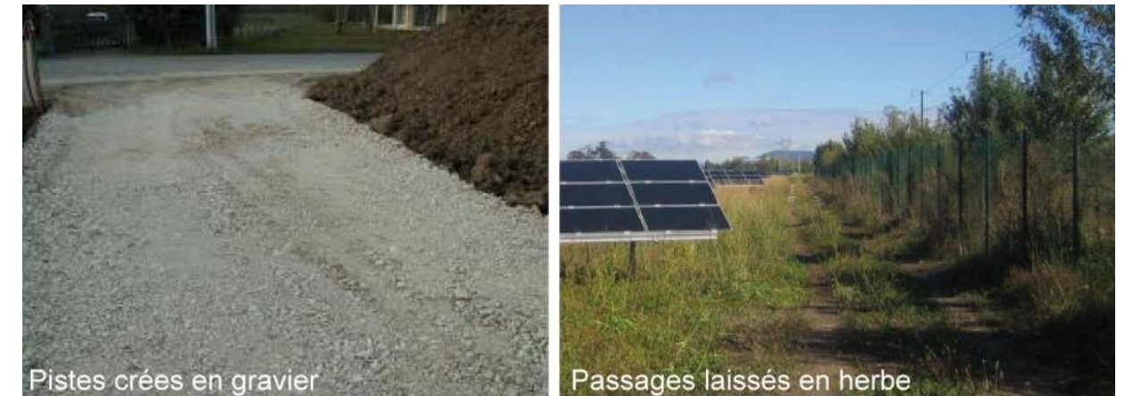
Photographie 5 : Pistes internes (Source : ENCIS Environnement)
