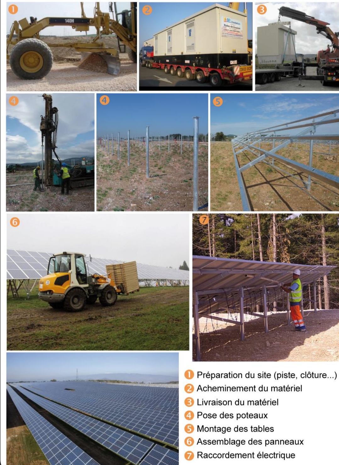
Photographie 1 : Construction d'une centrale photovoltaïque
