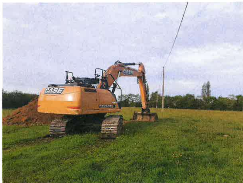
Figure 10. Mise en œuvre des travaux
