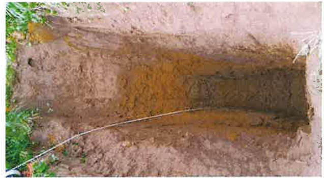
Figure 15 : Fouille F2 entre 0,00 à 3,50 m
