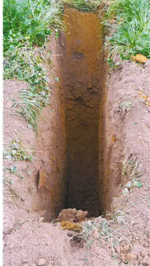
Figure 23 : Fouille M1 entre 0,00 à 3,00 m
