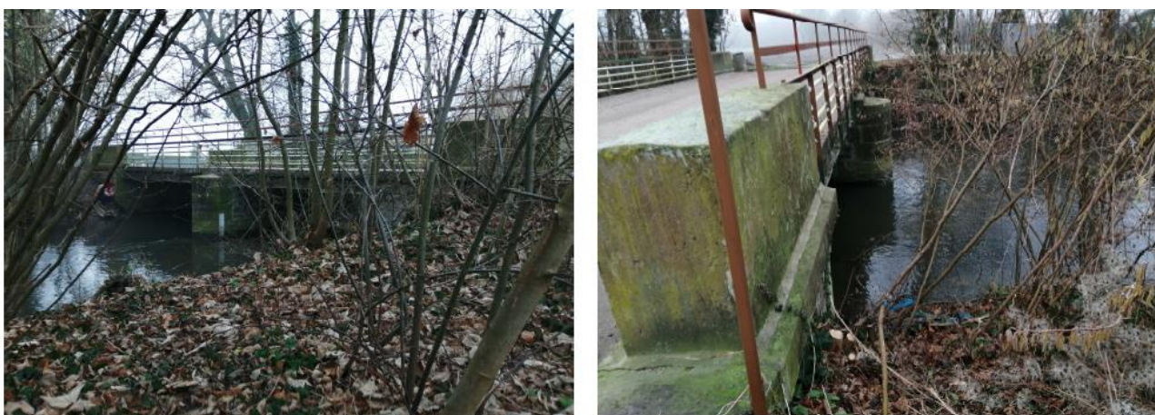
Figure 5 : Ouvrage d'art au-dessus de l'Ehn
