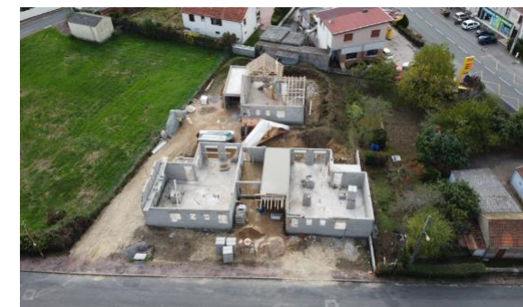
Pendant les travaux
