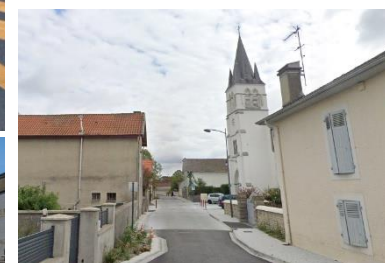
RD37 à Mazères-Lezons : rétrécissement progressif de la chaussée, changement de matériau
