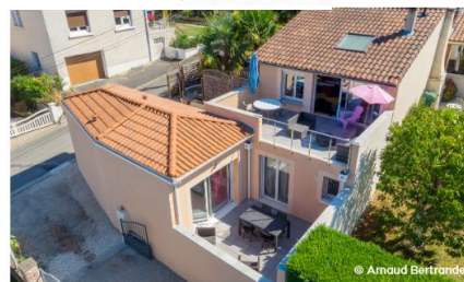
Une fois les travaux terminés
