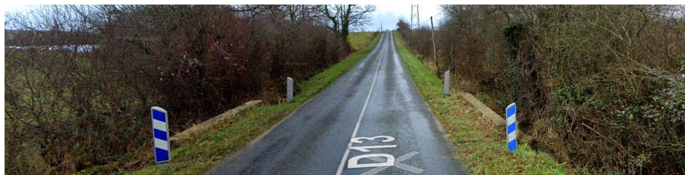
Figure 89 : L'affluent temporaire des Fourniers au niveau de la route D 13 (Source : Google)
