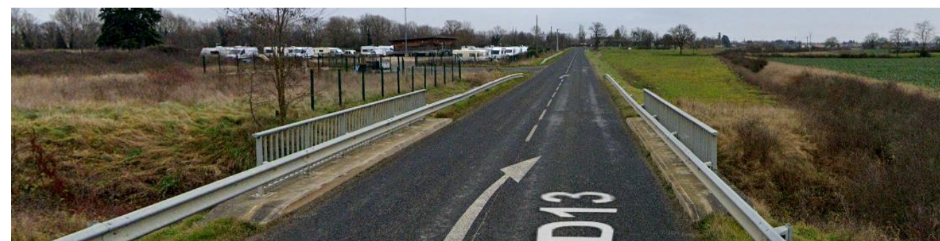
Figure 94 : Traversée de la Goutte Noire (Source : Google)
