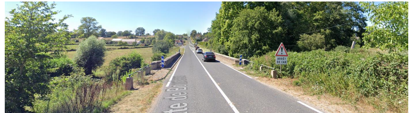
Figure 99 : Traversée de l'Ours par la route D 953 (Source : Google)
