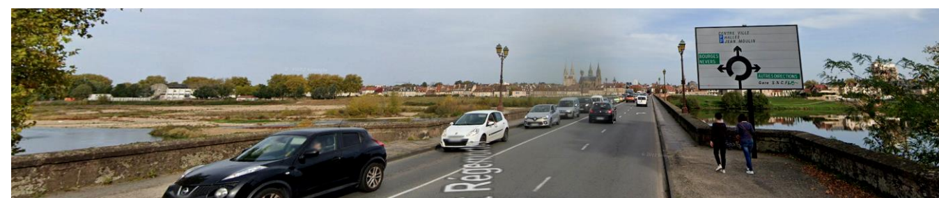
Figure 95 : Traversée de l'Allier au niveau du pont Régemortes (Source : Google)
