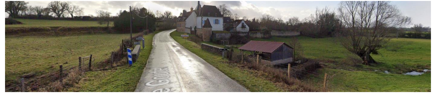
Figure 98 : Pont sur le Goutet, à l'entrée de Saint-Menoux (Source : Google)
