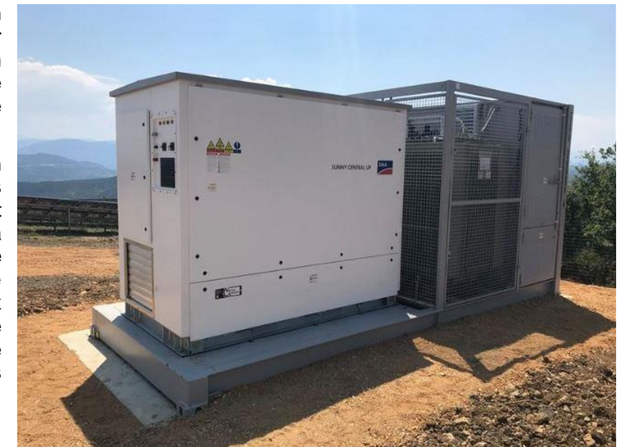
Photo 4 : Exemple de poste de transformation (BORALEX)
