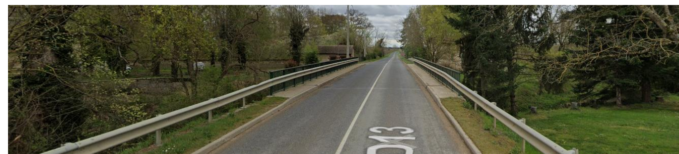
Figure 93 : Pont au-dessus de la Queune (Source : Google)
