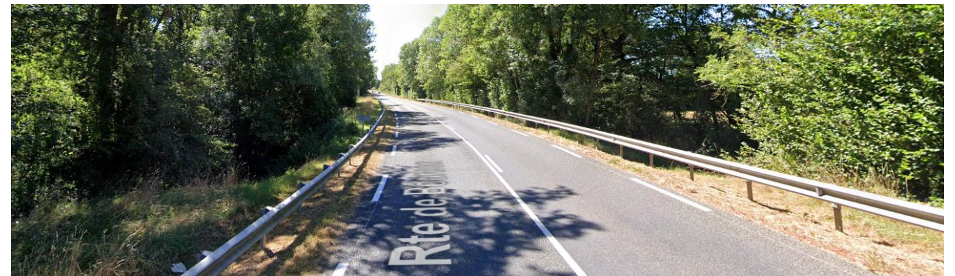
Figure 100 : Pont au-dessus du ruisseau des Vesvres (Source : Google)
