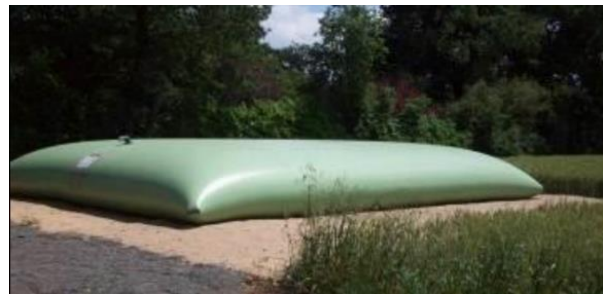
Photo 7 : Exemple de citerne incendie souple (Source : BORALEX / SOLATERRA)
