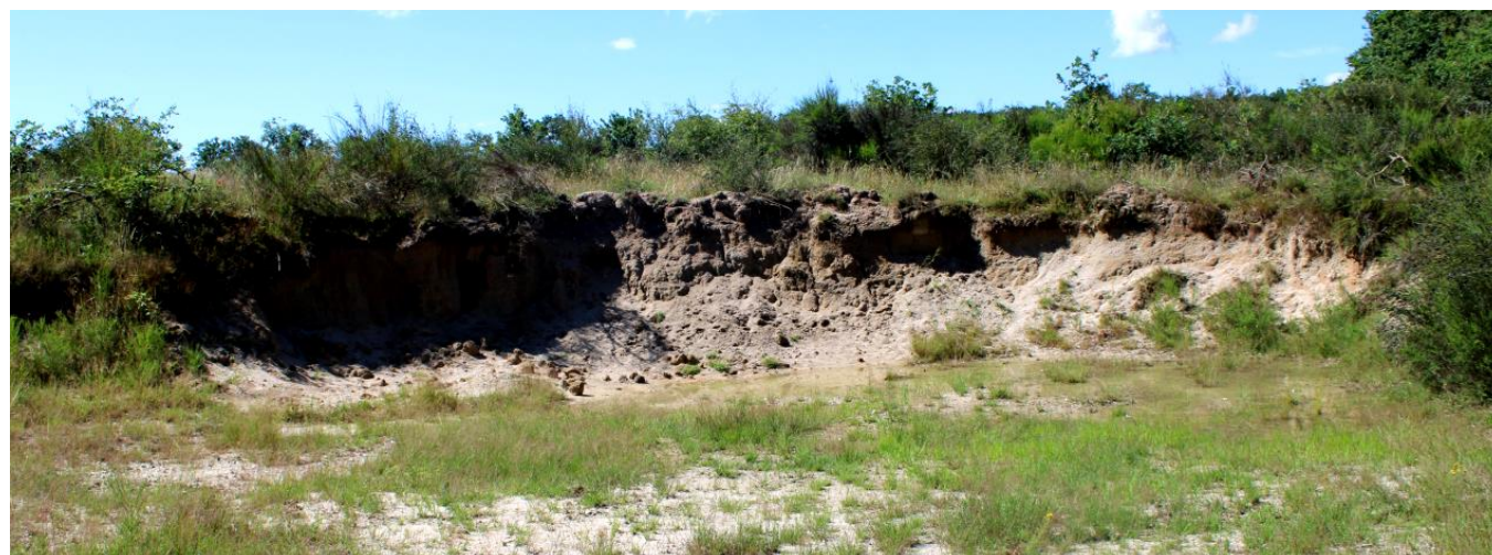
Photo 13 : Affaissement du sol à l'est des étangs
