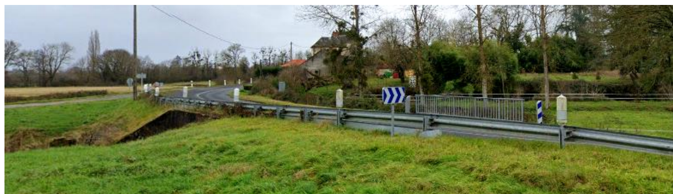
Figure 90 : Le pont sur l'Allier, au niveau de la route D 13 (Source : Google)
