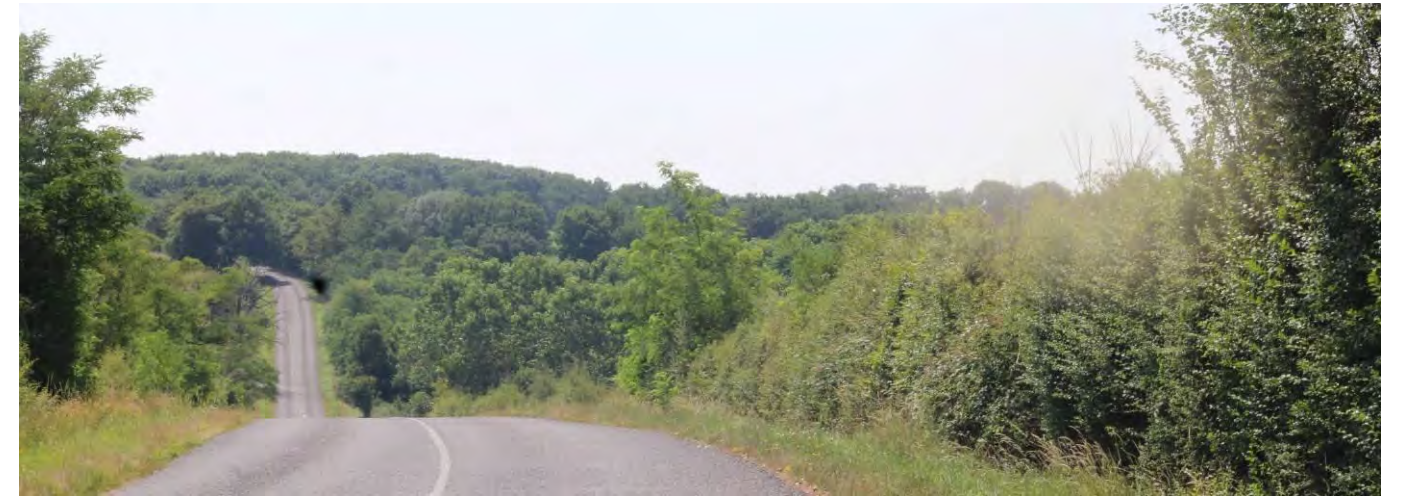
pdv 20 : La D101 au niveau du franchissement du ruisseau des Fourniers : les vues sont très fermées.
