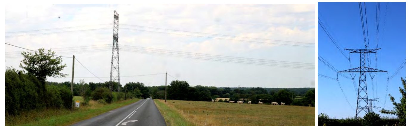
Photo 46 : La ligne électrique THT 400 kV (ici, vue depuis la route D 13)
