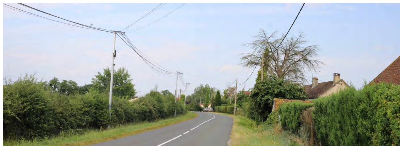
pdv 16 : Les habitations de la Promenade, le long de la D13
