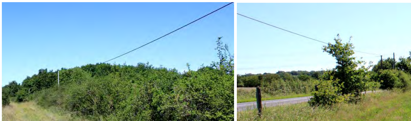
Photo 47 : Ligne téléphonique en limite nord du site d'étude
