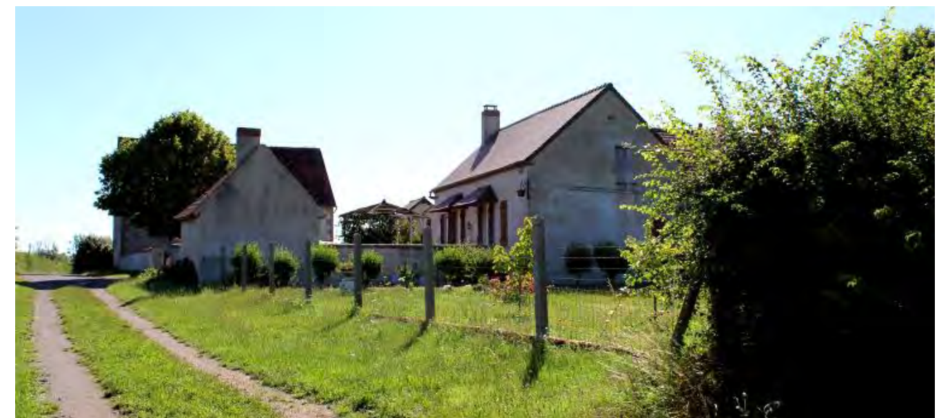
Photo 52 : Les habitations proches (en haut, les habitations à 163 m au nord du site et en bas, celles à 48 m à l'est)
