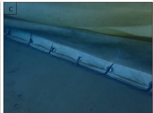
Schéma d'un rideau anti-MES (Photo A) – Partie haute d'une barrière anti-MES (Photo B) – Partie basse d'une barrière anti-MES (Photo C)
