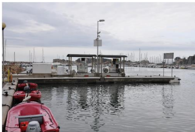
Figure 14 : Vue de la station d'avitaillement
