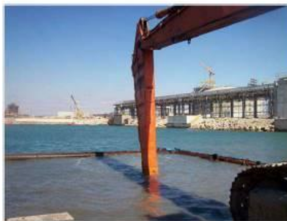
Figure 54 : Dragage dans un barrage anti-MES
