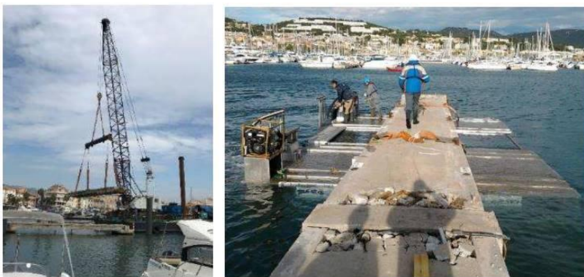
Figure 51 : Levage d'une travée béton par grue sur barge (à gauche), dépose avec un caisson – panne C, 2013 (à droite)
