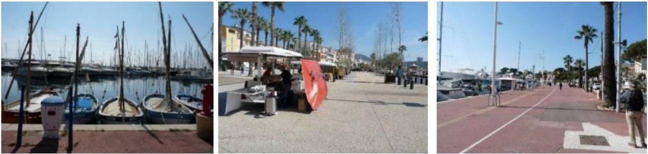
Figure 131 : Vues depuis le quai principal du port (source : PLU, 2023)
