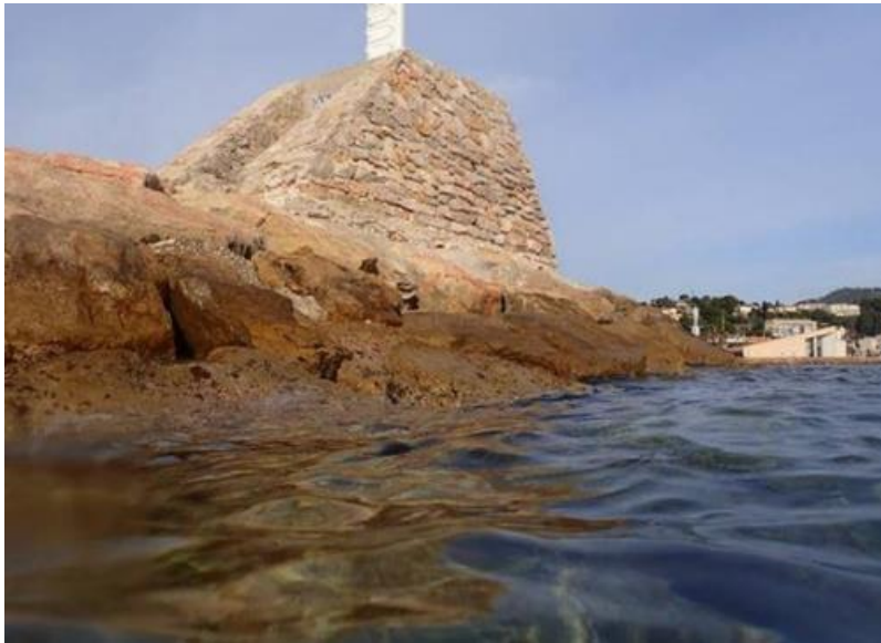
Figure 109 : Prise de vue des enrochements de la digue (étages supra et médiolittoral)
