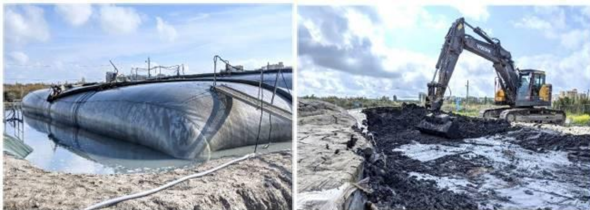
Figure 60 : Géoconteneurs filtrants en cours de remplissage et d'ouverture après déshydratation
