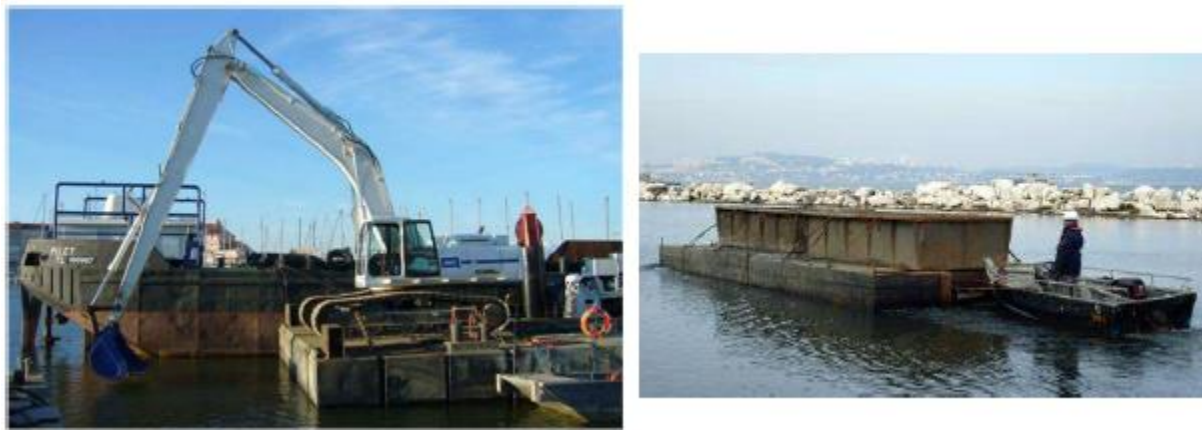
Figure 53 : Atelier ponton pelle et barge de transport des sédiments
