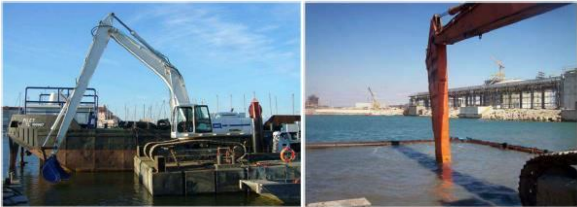
Figure 26 : Atelier ponton pelle et barge de transport des sédiments - Dragage dans un barrage anti-MES
