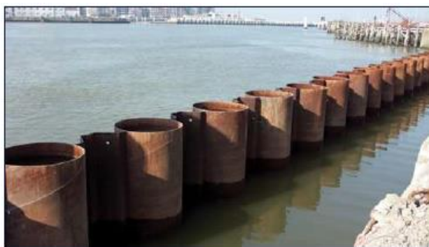
Figure 31 : Exemple de combiwall
