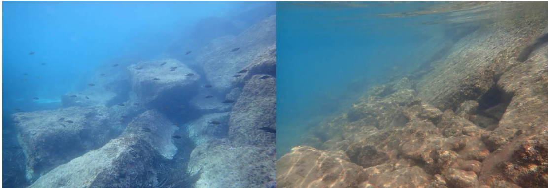
Figure 41 : Prises de vue des enrochements des digues à l'extérieur du port (gauche) et à l'intérieur (droite)
