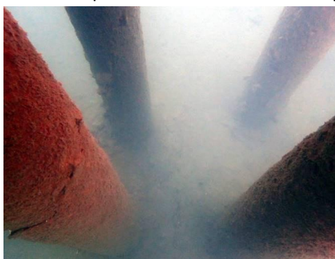
Figure 38 : Prise de vue de vases portuaires au niveau des appuis pieux d'un appontement
