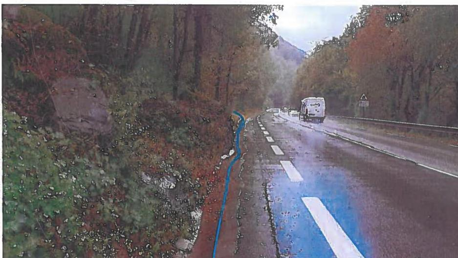
Figure 1: Photo de la zone d'implantation de la canalisation de restitution (en bleu) sous la cunette. Prise de vue en direction de Gavet.
