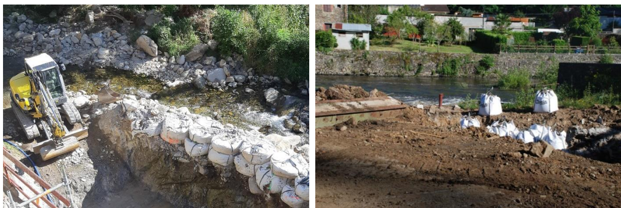
Figure 13 : Exemple de batardeaux en big-bags (chantiers Valorem)
