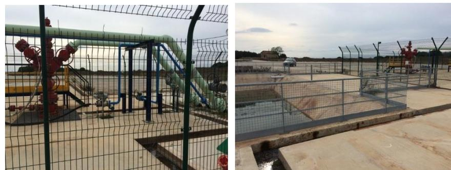
Plateforme cimentée de la tête de puits du PA28-29 (gauche) et son réseau de caniveaux vers le bournier cimenté (à droite)
