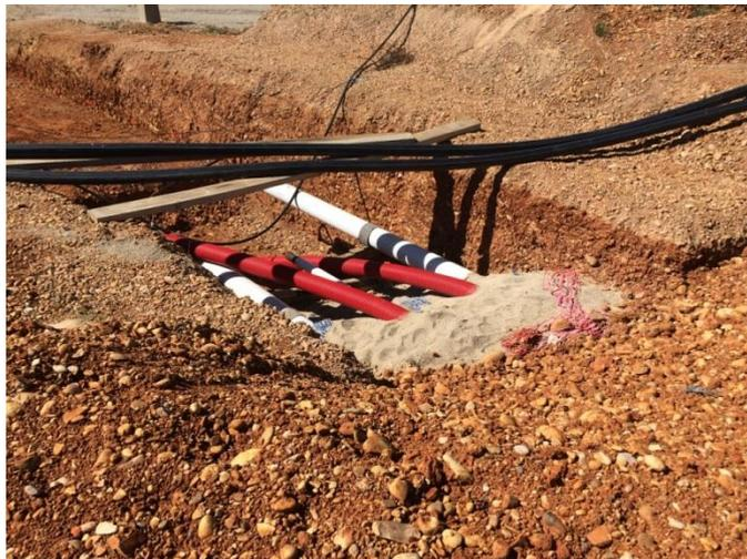
*Prise de vue d'une tranchée : En rouge : gaines pour l'alimentation électrique et pour les télétransmissions ; En blanc : Tuyaux de l'injection d'eau et du retour saumure.*
