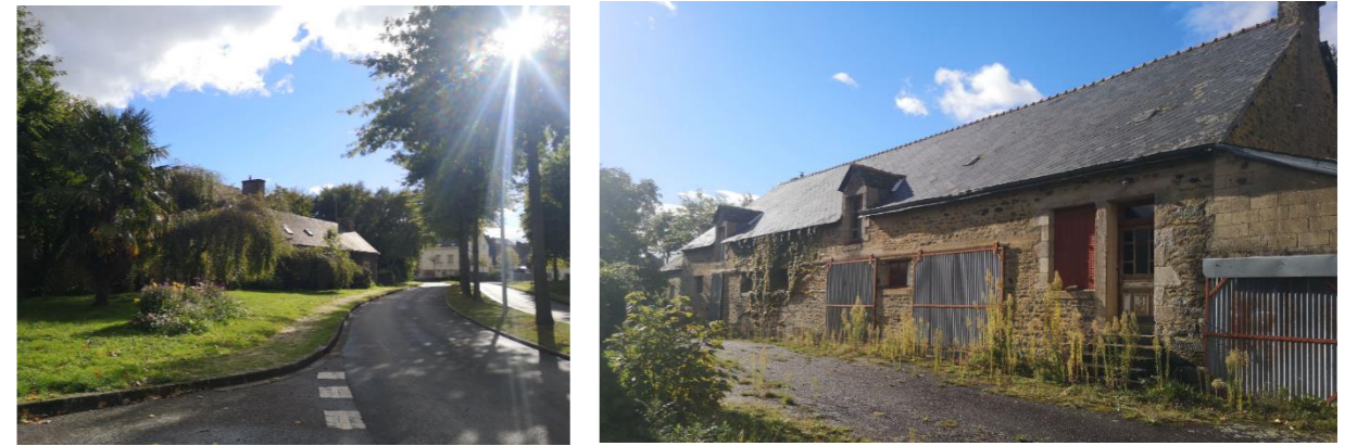
Bâtiment vacant pour lequel la démolition est en questionnement, Evellys - Naizin
