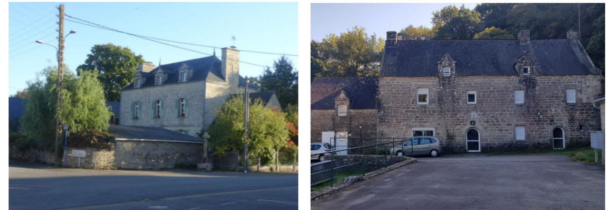
Création de logements dans un ancien presbytère, Buléon (à gauche), Billio (à droite)
