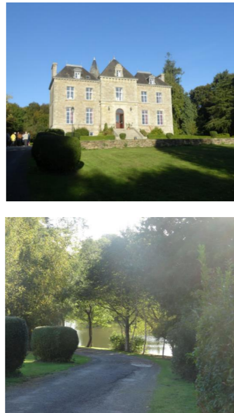
Figure 31 Le Domaine de La Ferrière, transformé en hôtel restaurant, Buléon
