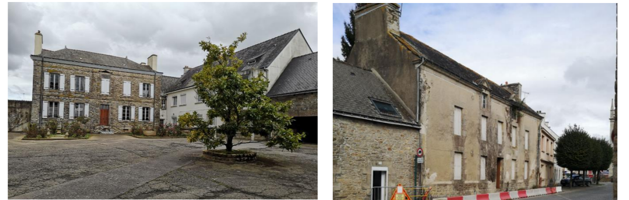
A gauche : Hypothèse de déconstruction de l'aile plus récente, à droite : déconstruction du bâti mais conservation de la façade sur rue, projets dans le cadre d'un global en centre bourg, Moréac
