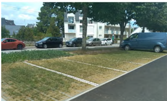
Fonction de stationnement + fonction hydraulique = parkings perméables
