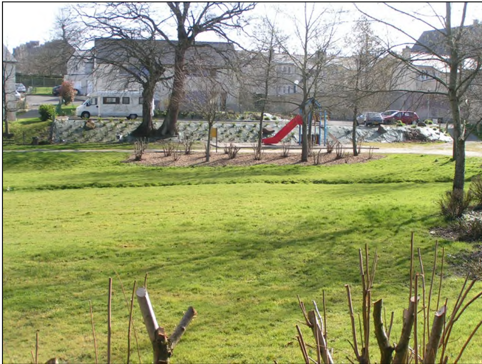
Figure 36 : Bassin pouvant servir d'aire de jeu lorsqu'il est à sec
