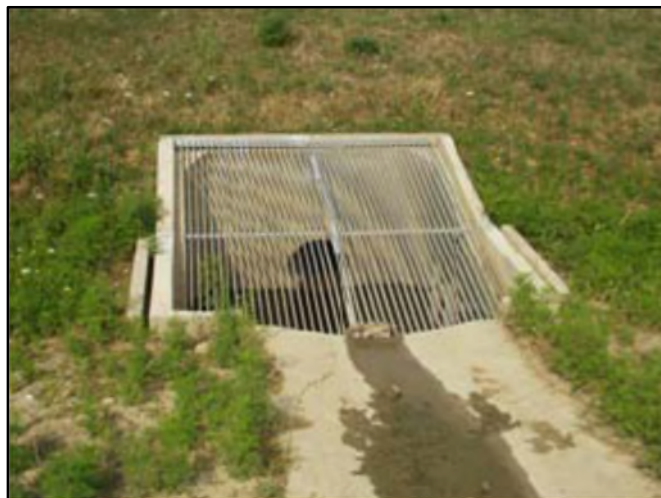
Figure 19 : Grille de protection sur ouvrage de sortie
