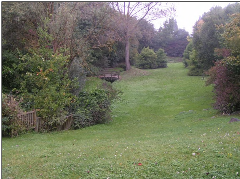
Figure 37 : Bassin servant de parc lorsqu'il est à sec
