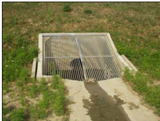
Figure 19 : Grille de protection sur ouvrage de sortie
