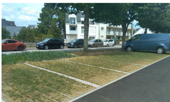
Fonction de stationnement + fonction hydraulique = parkings perméables
