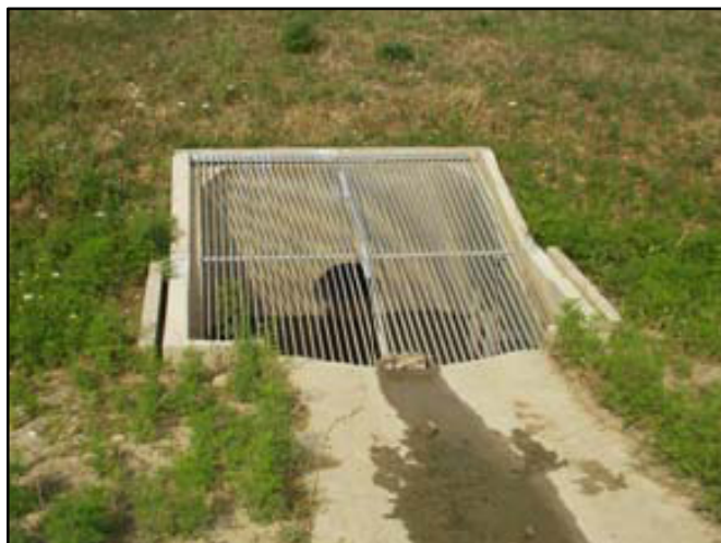
Figure 19 : Grille de protection sur ouvrage de sortie
