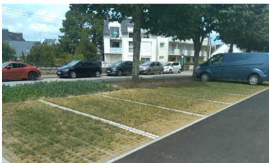
Fonction de stationnement + fonction hydraulique = parkings perméables
