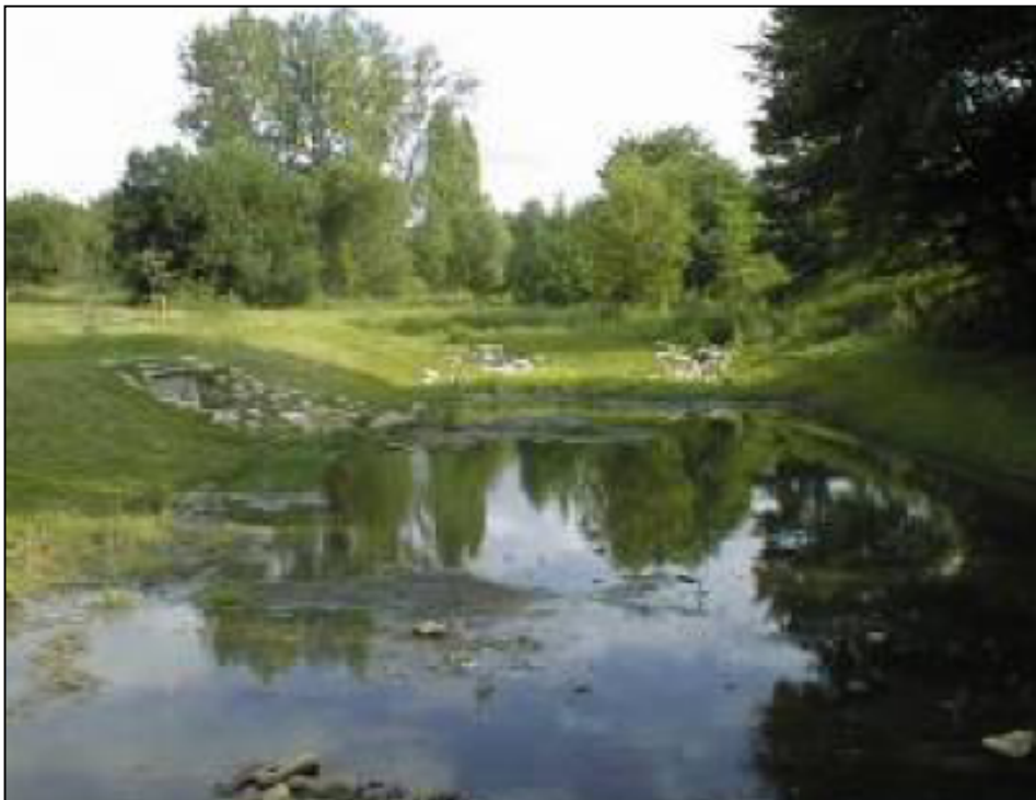
Figure 35 : Bassin paysager en eau
