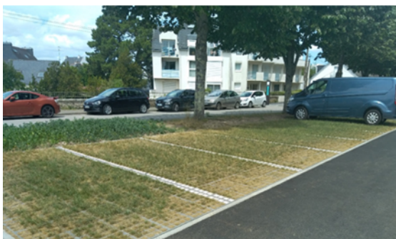
Fonction de stationnement + fonction hydraulique = parkings perméables
