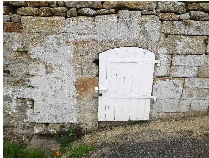
Puits dans mur du 6 rue des Mégalithes
