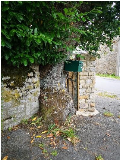
Arbres dans un mur de clôture
