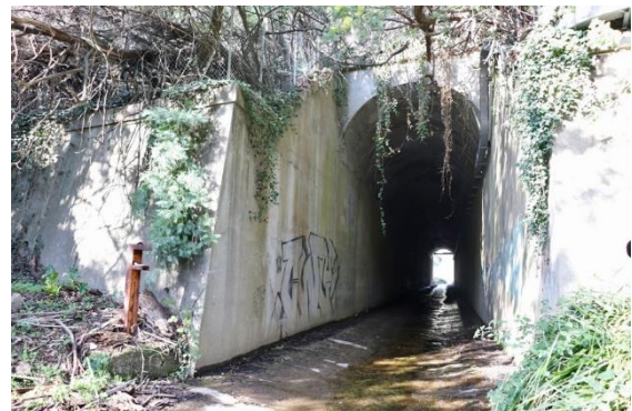
Passage inférieur et rétablissement hydraulique sous l'A8
