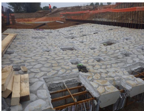
Figure 18 : Principe de radier à macrorugosités – Exemple de réalisation sur le barrage de la Turdine
