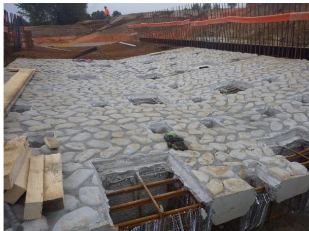
Figure 18 : Principe de radier à macrorugosités – Exemple de réalisation sur le barrage de la Turdine
