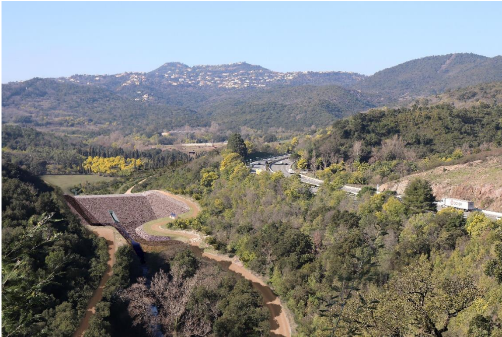
Figure 104: Photomontage de l'ouvrage en remblais zonés avec enrochements sur le site – Vue depuis le point haut le plus proche situé à l'aval (EGIS Eau, 2019)
