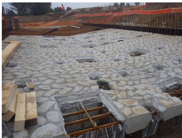
Figure 48 : Principe de radier à macrorugosités – Exemple de réalisation sur le barrage de la Turdine
