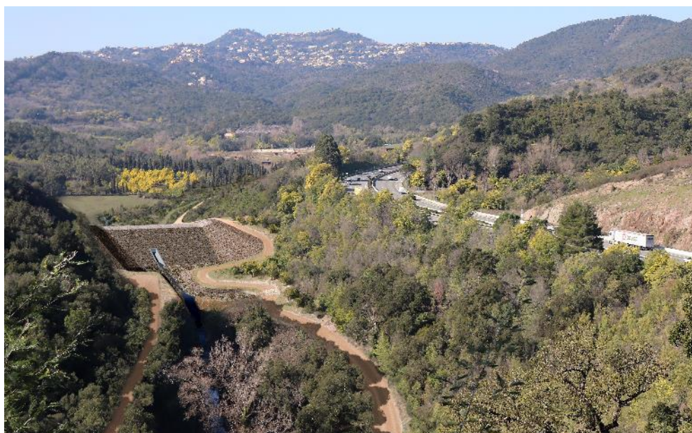
Photomontage de l'ouvrage en remblais zonés avec enrochements sur le site – Vue depuis le point haut le plus proche situé à l'aval (EGIS Eau, 2019)
