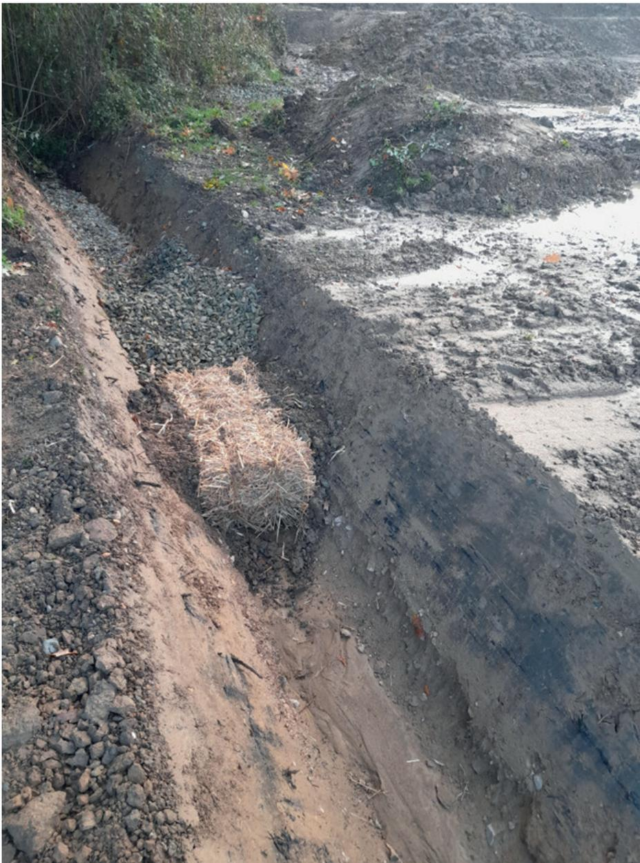
Figure 199 : Mise en place d'une filtration en phase chantier avant rejet au milieu récepteur
