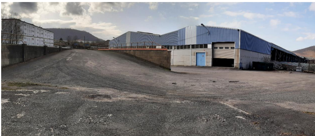
Vue du site avant travaux de démolition en avril 2021
