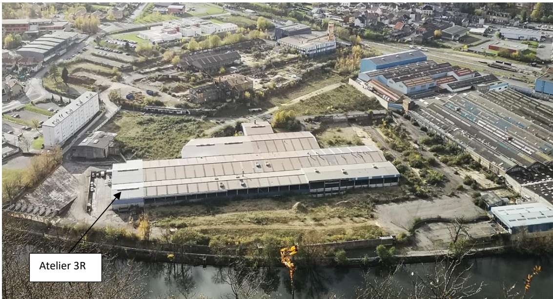
Vue aérienne du site après rénovation et installation de l'atelier 3R en avril 2023
