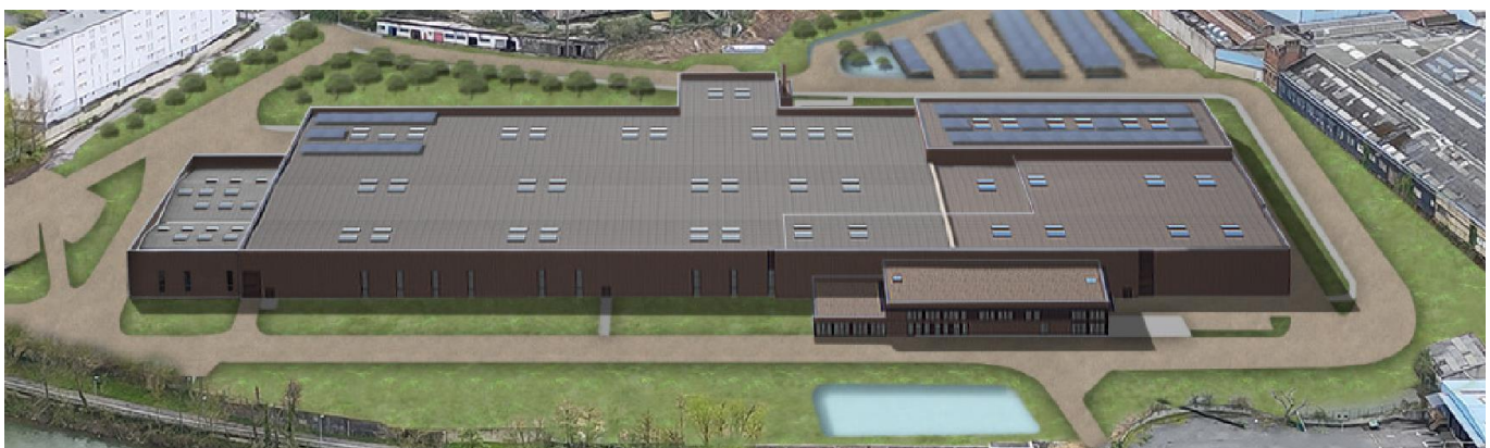
Aspect de l'atelier 3R déjà terminé et montrant l'aspect extérieur futur de l'ensemble de l'usine.
