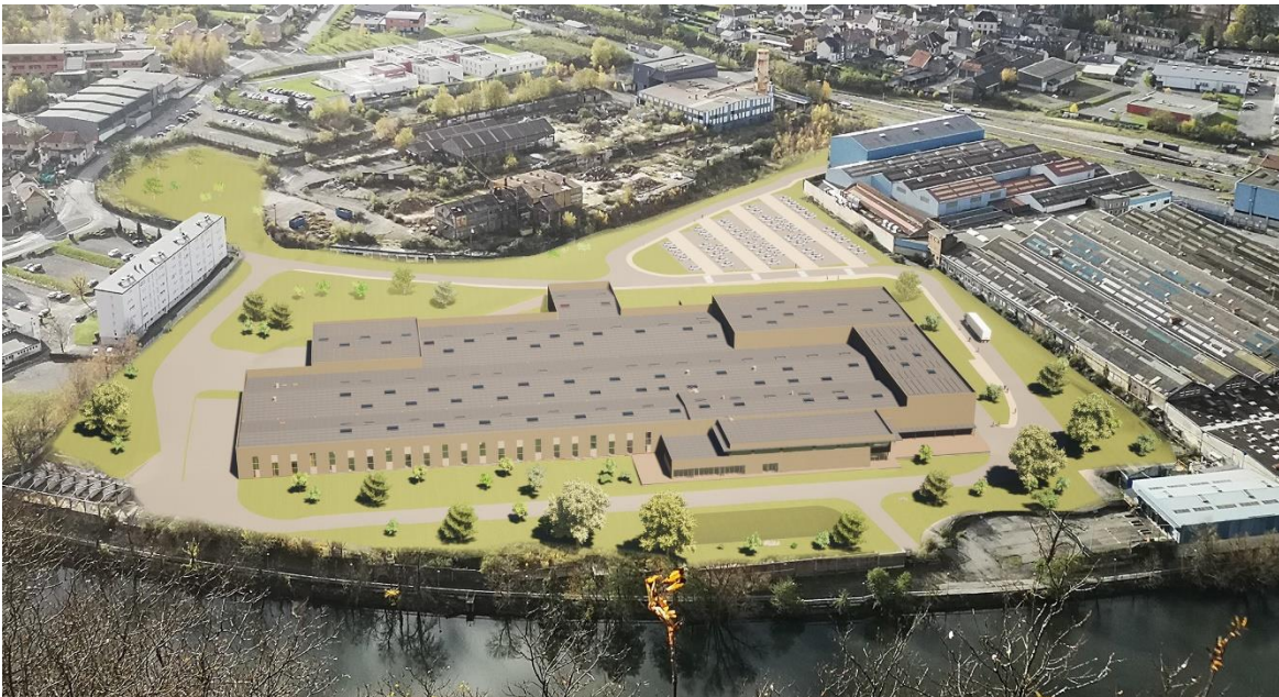
Vue aérienne du projet Juillet 2023
