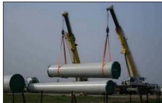
Photo 16 : Manipulation des tronçons d'éoliennes
