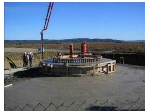
Photo 13 : Coulage du béton
