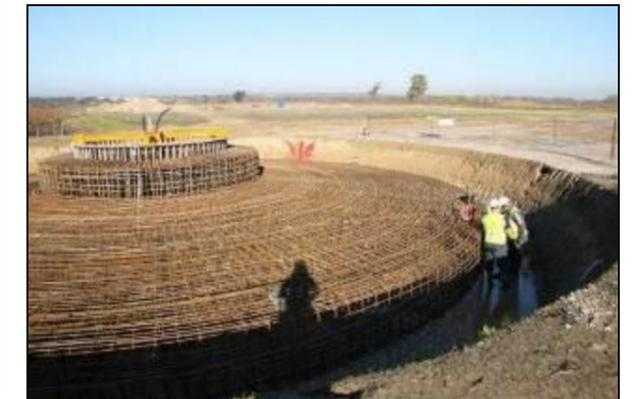
Photo 12 : Ferrailage de la fondation
