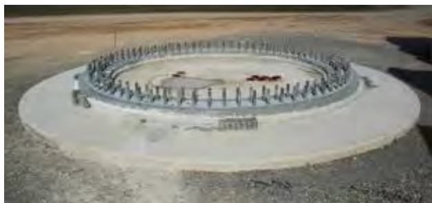
Photo 4 : La fondation terminée
