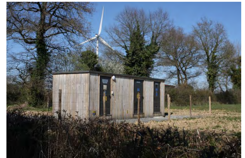
Illustration 36 : exemple de poste de livraison avec bardage bois vertical (source Abies)
