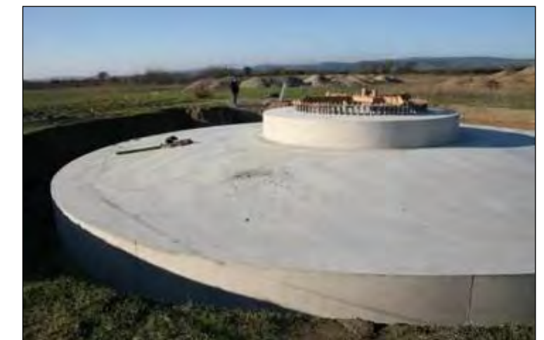
Photo 16 : La fondation terminée
