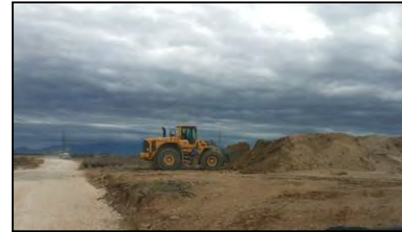
Figure 121 : Reprise de la terre stockée pour le remblayage des fondations (Source : Abies, suivi de chantier éolien)
