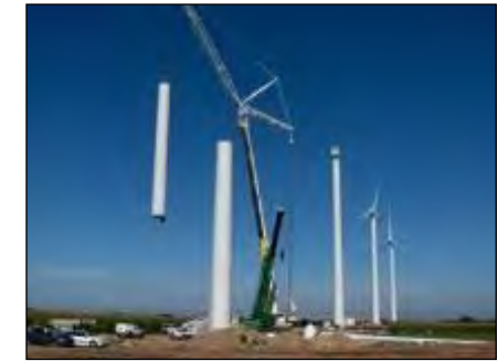
Photo 22 : Vue d'ensemble des étapes d'assemblage de la tour (exemple de tour en acier)
