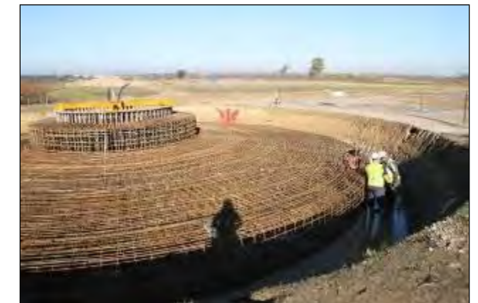
Photo 14 : Ferrailage de la fondation
