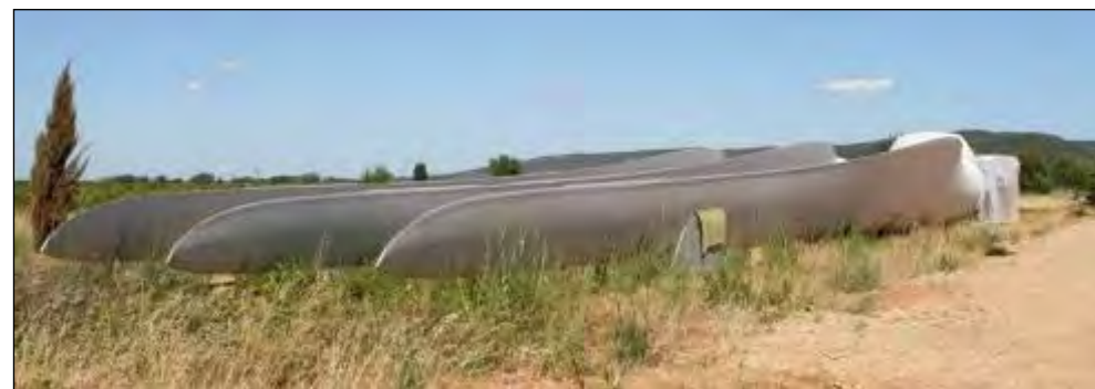
Photo 21 : Pales entreposées sur un chantier éolien
