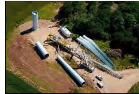
Photo 22 : Vue d'ensemble des étapes d'assemblage de la tour (exemple de tour en acier)
