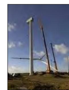
Photo 24 : Hisse et assemblage du rotor
