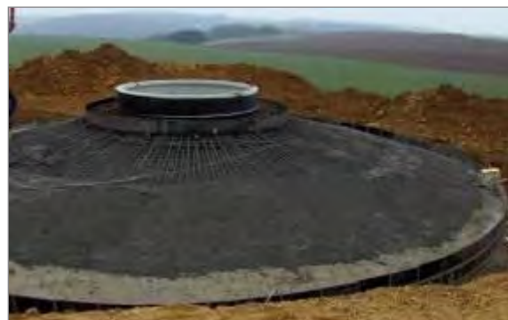
Photo 3 : Exemple de ferrailage en radier pour une éolienne
