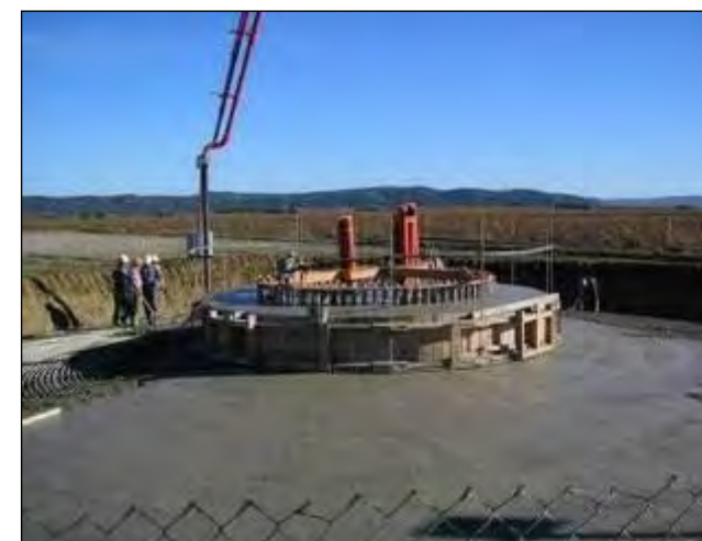
Photo 15 : Coulage du béton
