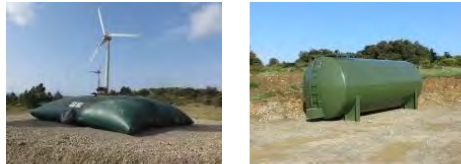
Citerne souple de 30 m 3 (à gauche) et citerne rigide (à droite) présents sur le parc éolien de Conilhac-Corbières, 11 (Source : Abies)
