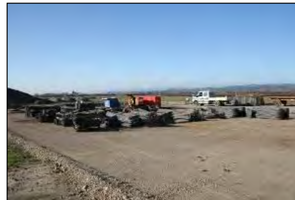
Photo 12 : Stockage des ferrailles
