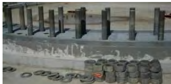
Photo 5 : Détail des fixations de la fondation
