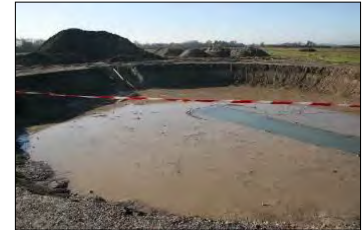
Photo 11 : Fouille de la fondation
