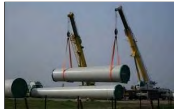
Photo 20 : Manipulation des tronçons d'éoliennes
