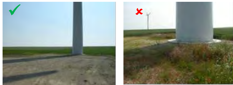
Exemples de revêtement au pied des éoliennes : à gauche, plateforme dépourvue de végétation (à favoriser) ; à droite, friche herbacée attractive se développant au pied d'une machine (à éviter).
