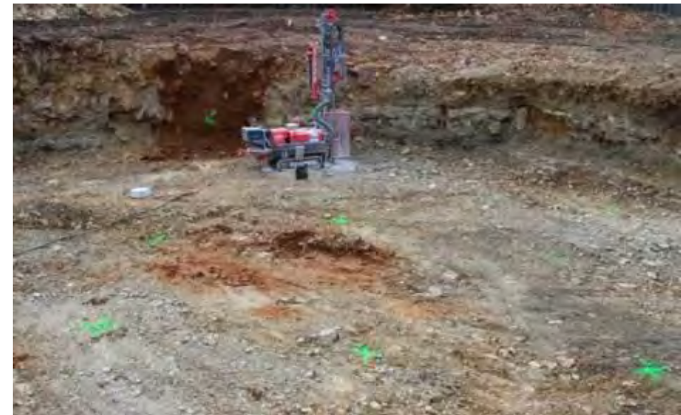
Figure 116 : Foreuse géotechnique sur un chantier éolien (Source : Abies)
